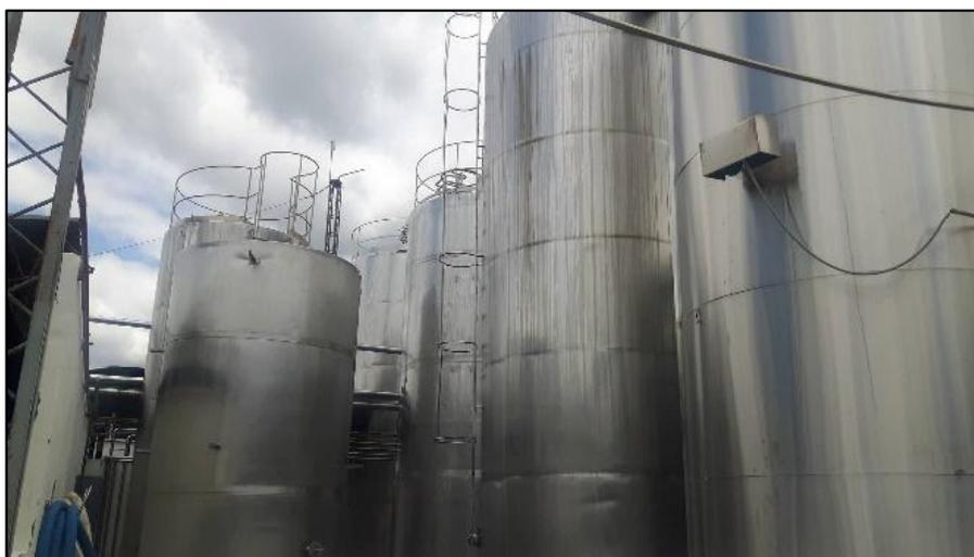
Figura 7. Tanques de almacenamiento capacidad total de 140.000litros. Fuente. Autor
