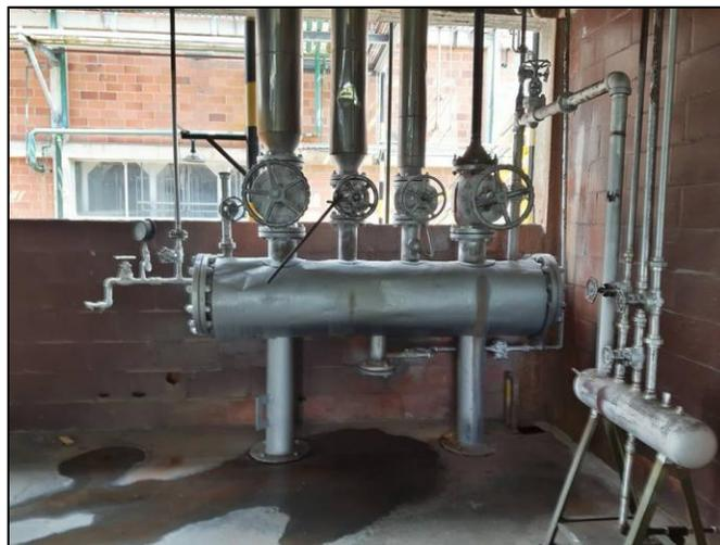
Figura 24. Tanque almacenamiento de vapor. Fuente. Autor
