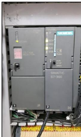
Figura 36. Plc siemens S-7 disponible en tablero de control. Fuente. Autor
