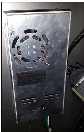
Figura 35. Fuente principal de 110 v – 24 v DC del tablero de control. Fuente. Autor
