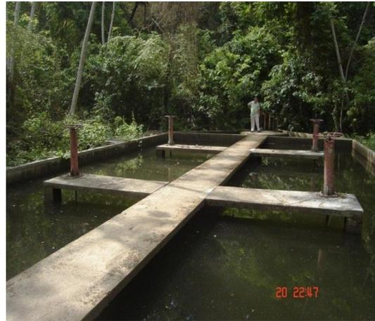
**ADUCCION:** Gracias a este proceso transportamos el agua hasta la planta de tratamiento por medio de canales y tubos de conducción. En los recorridos desde las bocatomas hasta los Desarenadores y de estos a la planta de tratamiento se presentan algunas perdidas por fugas y conexiones por parte de habitantes de fincas cercanas. Las tuberías de conducción hasta la planta son dos de 10” y una de 12”.
