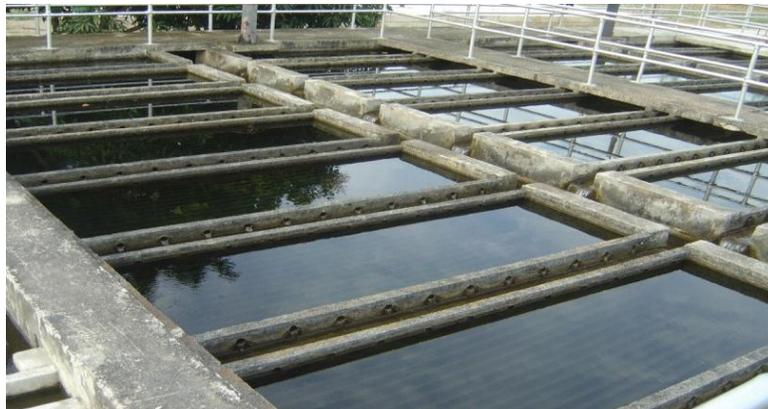
**FILTRACION:** Proceso mediante el cual se remueve las partículas suspendidas y coloidales del agua al hacerlas pasar a través de un lecho poroso. Filtración: Esta sección consta de 10 filtros convencionales, de los cuales dos están recientemente construidos. Estos en su interior constan de un material conformado por grava arena y antracita.
