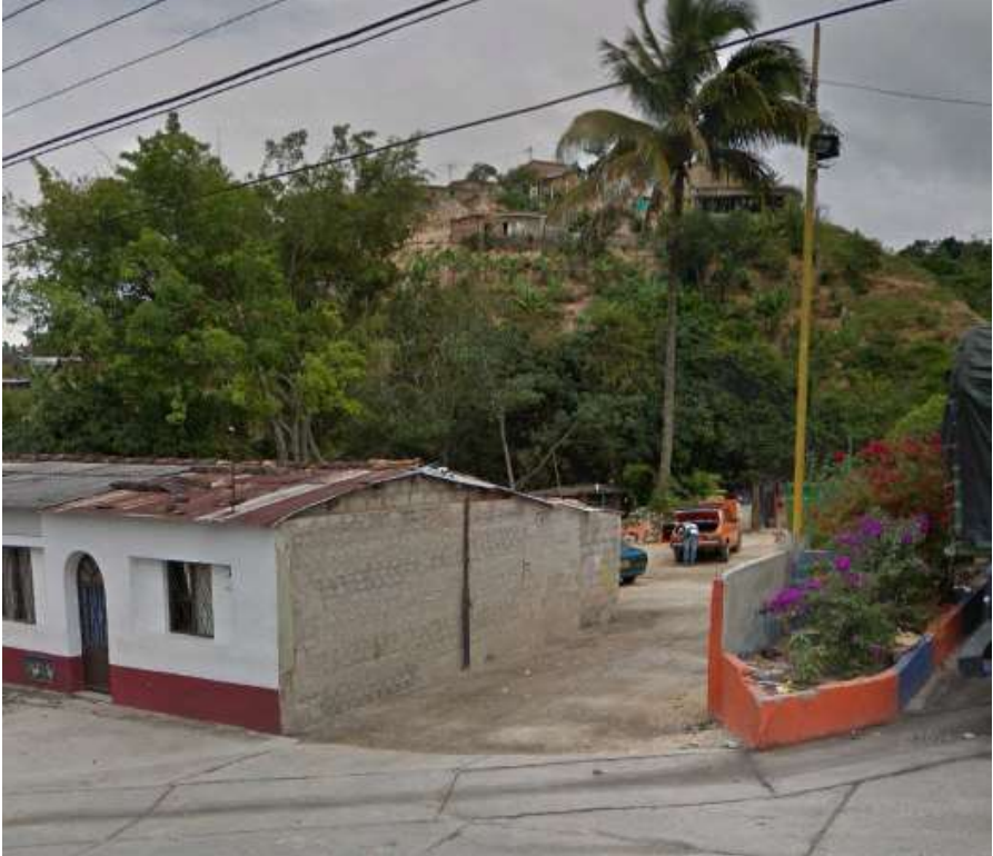
Imagen 4. Sitio de almacenamiento ilegal de combustible 2.
