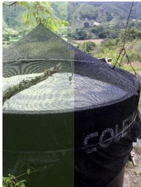
Foto 28. Polisombra en tanque de almacenamiento
