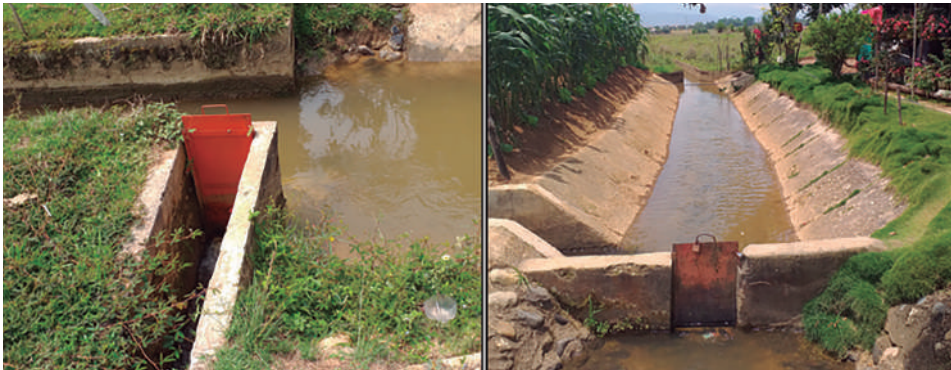
Figura 38. Compuerta plana
