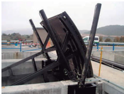
Figura 39. Compuerta radial
