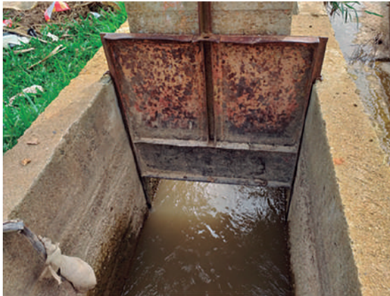
Figura 40. Compuerta deslizante
