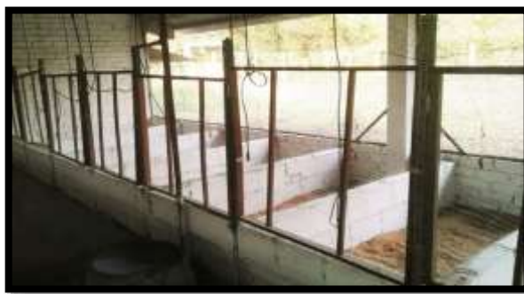
Figura 7. Sistema de alojamiento en piso. Fuente: Autores del proyecto
