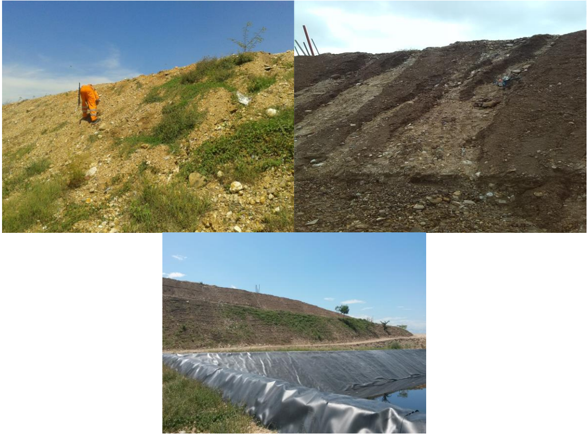
Foto 15. Seguimiento al talud.
