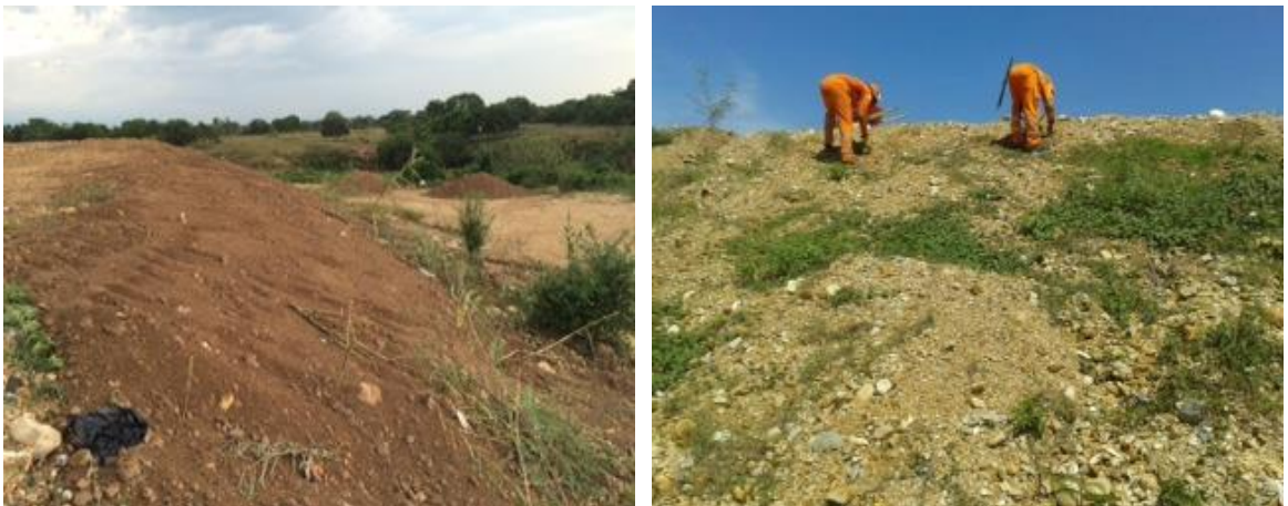
Foto 13. Talud perteneciente a la zona sur.
