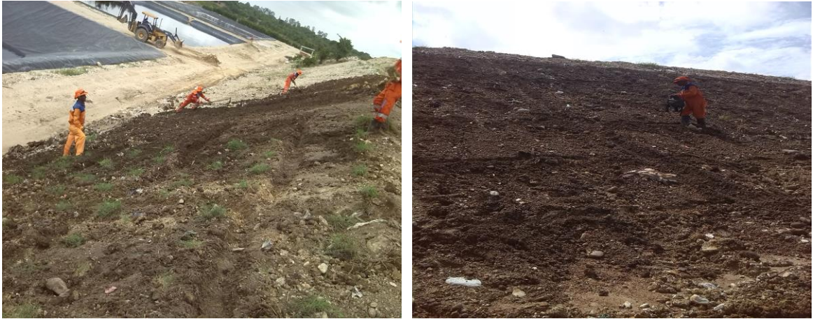
Foto 12. Talud perteneciente a la zona occidental.
