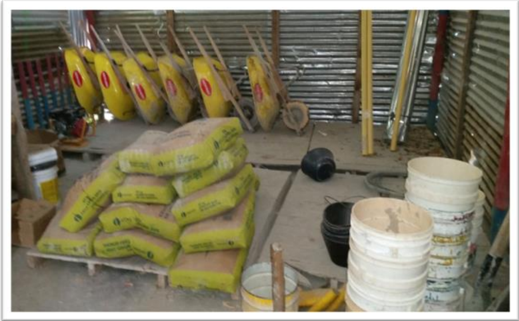
Foto 13. Frente de obra almacén
