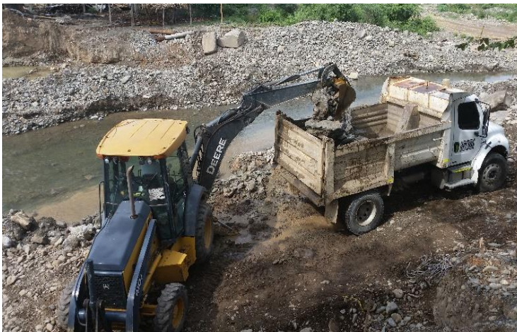
Foto 8. Manejo de escombros
