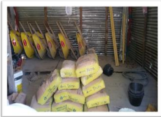
Foto 4. Acopio de cemento
