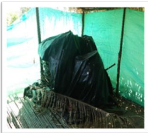
Foto 5. Acopio del acero
