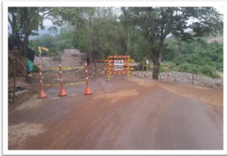
Foto 6. Señalización frente de obra
