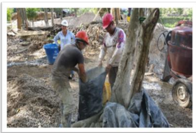
Foto 11. Jornada de limpieza en Obra.
