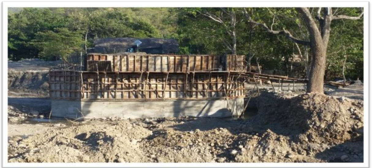
Foto 20. Estado actual de la Obra
