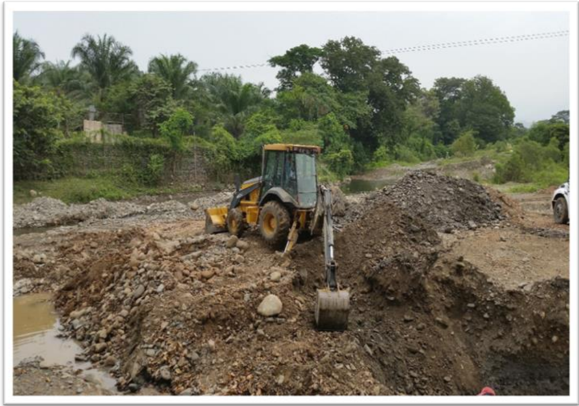
Foto 16. Maquinaria de la Obra
