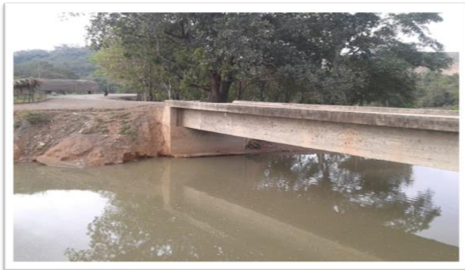
Foto 1. Sitio del proyecto construcción puente sobre el río Tucuy.
