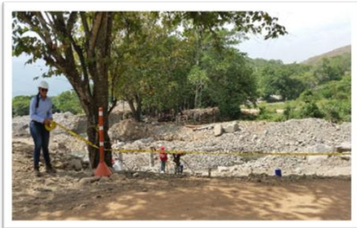
Foto 7. Señalización frente de obra
