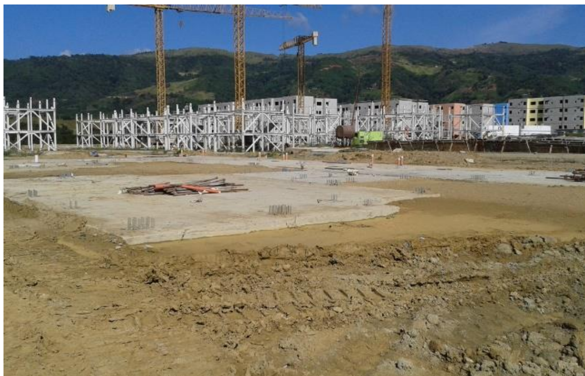
Fotografía 4. Vaciado de losas de fundación.
