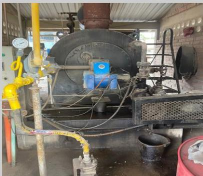
La caldera produce calor quemando el combustible con el que trabaja, esta calienta los 3 tanques de asfalto que posee la planta.
