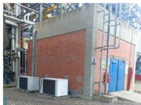
*Nota.* En la imagen se logra apreciar las unidades de condensación del edificio carbones.
