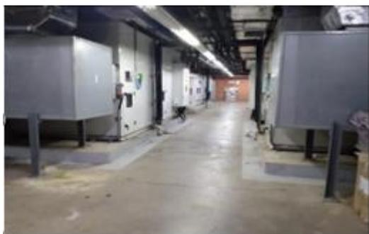
*Nota.* En la imagen de la parte izquierda se encuentran las unidades de evaporación del aire enfriado del edificio turbina.
