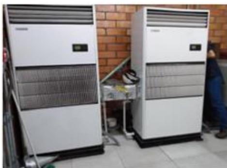
*Nota.* En la imagen se logra apreciar las unidades de evaporación del aire enfriado del edificio carbones.
