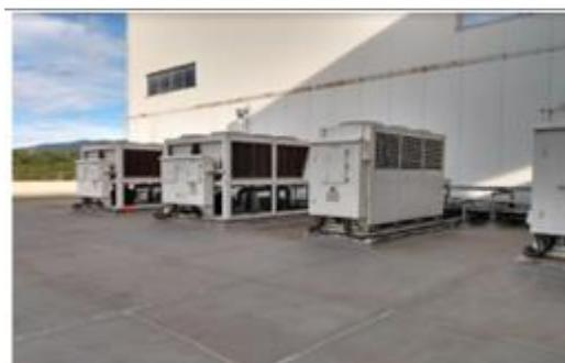
*Nota.* en la imagen del lado derecho se encuentran las unidades de condensación del edificio turbina.
