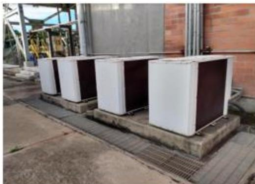
*Nota.* En la imagen se logra apreciar las unidades de condensación de aire del edificio planta de agua.
