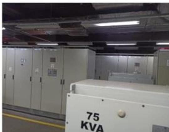
*Nota.* En la figura se muestran los gabinetes de las salas de control de motores en la parte, donde se encuentran inversores, cargadores y transformadores de energía de la planta.
