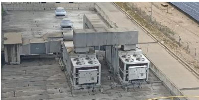
*Nota.* En la figura se evidencian las unidades tipo paquete de aire acondicionado del edificio AQCS.
