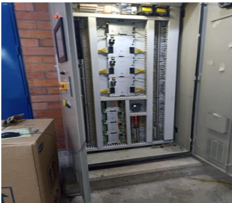
*Nota.* En la figura 14 se muestra el PLC de control del sistema de aire acondicionado actual, el cual no se encuentra funcional.
