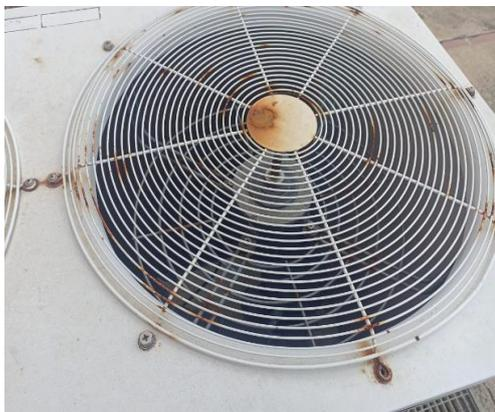
*Nota.* La figura muestra unidad condensadora del edificio carbones sin el ventilador disipador de calor.
