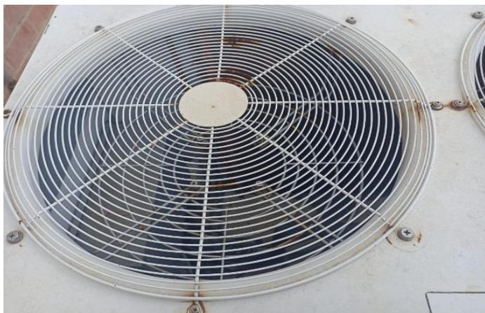
*Nota.* La figura muestra una unidad condensadora del edificio planta de agua, sin su respectivo motor y ventilador disipador de calor.
