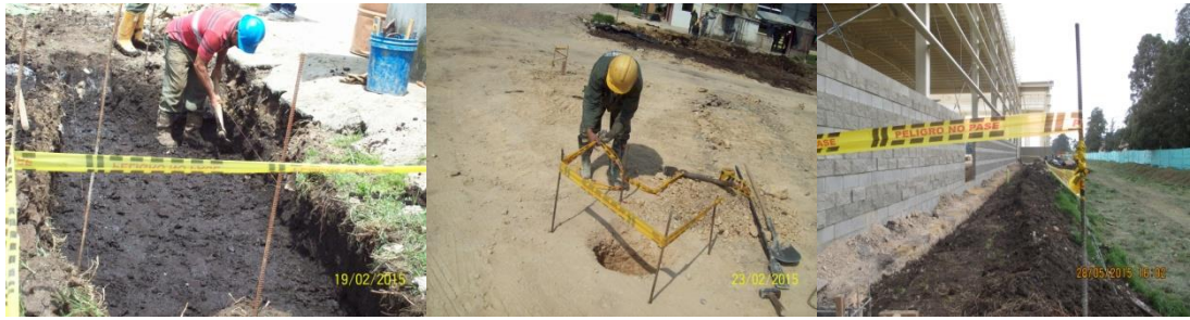
Foto 23. Señalización interna en obra.
