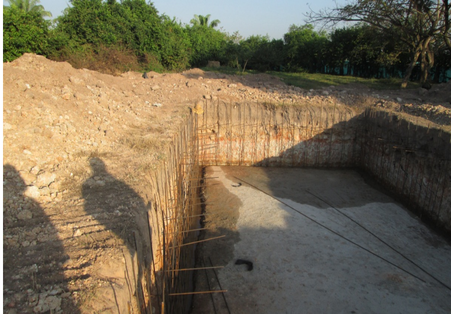
Fotografía 7: Construcción de Reactor Biológico.
