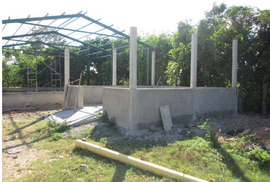
Fotografía 5: Construcción de estercolero en su fase de terminación.
