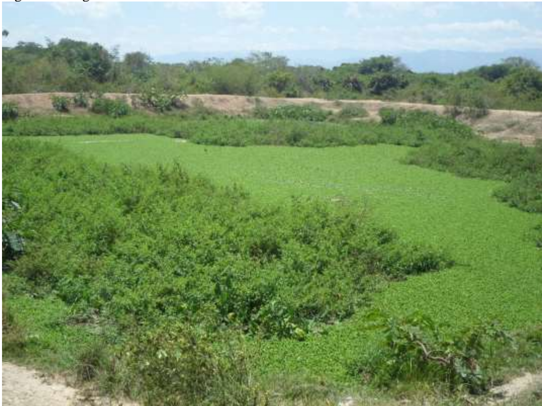
Figura 11. Laguna de oxidación 1
