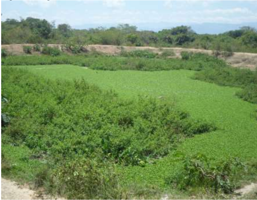
Figura 9. Laguna de oxidación Dos.
