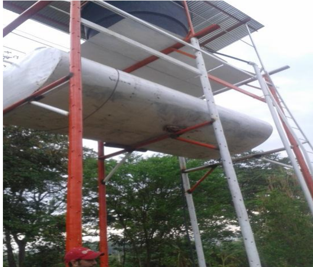
Foto 4. Tanque aéreo para riego
