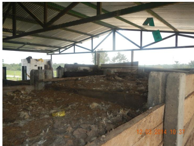
Fotografía No. 15 Compostera
