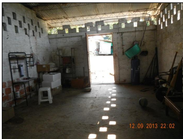
Fotografía No.11 Bodega de almacenamiento granja Oriente A
