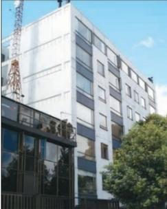
A modern building with a white facade and large windows, featuring a prominent antenna tower on the roof.  | <p>Edificio de 7 pisos ubicado en Bogotá para uso de apartamentos, construido con luces de 10 x 6 m, columnas cajón mixtas, viguetas en celosía, lamina colaborante formada en press brake.</p> <p>Imagen obtenida de: Vargas H. (2007)</p>  |
