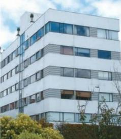
A modern building with a white facade and large windows, featuring a prominent antenna tower on the roof. | <p>Edificio de 6 pisos y dos sótanos ubicados en la ciudad de Bogotá, está construido con acero ASTM A36, con columnas tipo cajón mixtas, arriostramientos con diagonales excéntricos.</p> <p>La imagen es obtenida de: Vargas H. (2007)</p> |
