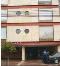
A multi-story building with a facade featuring circular windows and a prominent entrance.                   | <p>Estructura de acero importada desde Ecuador, fue el primer edificio en tener arriostramientos excéntricos, con vigas y columnas de acero cubiertas en concreto.</p> <p>La imagen es obtenida de: Vargas H. (2007)</p>                     |
