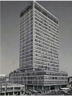
A tall, modern skyscraper with a grid-like facade, located in Bogotá.                                       | <p>Carrera 10 con Calle 14 centro de Bogotá. Construido en estructura de acero importado de EEUU, para espacios de oficina con 25 pisos para una altura de 89 metros.</p> <p>La imagen es obtenida de: Imágenes Corner (2020).</p>           |
