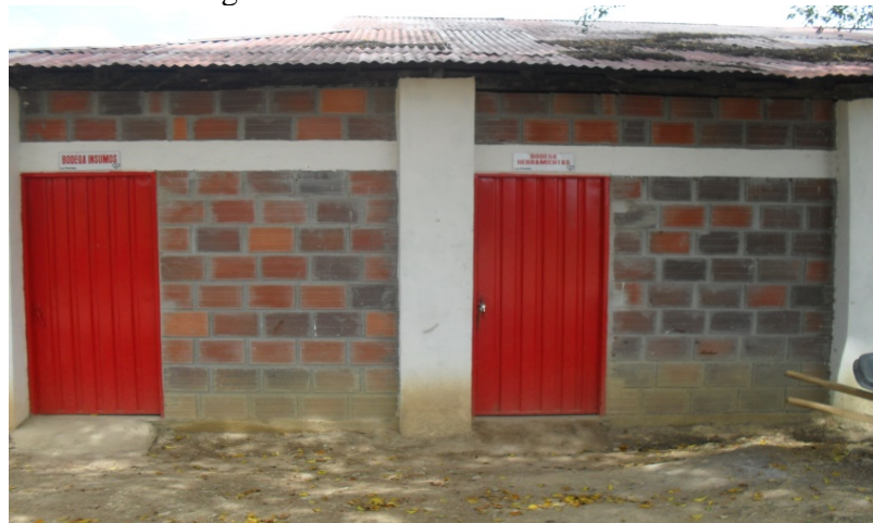
Foto 8. Construcción de bodegas
