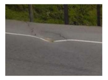
Nota. En la figura se puede apreciar, la patología correspondiente a hundimientos, la cual es ocasionada por asentamientos en la subrasante, los cuales tienen su origen en deficiencias presentadas al momento de compactar el terreno. Tomado de (Grupo Técnico - Convenio 587-03, 2006)
