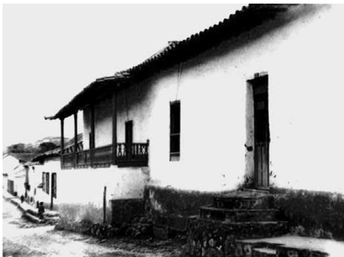
Figura 16. Fachada posterior Colegio José Eusebio Caro, calle 10 antes de la construcción
