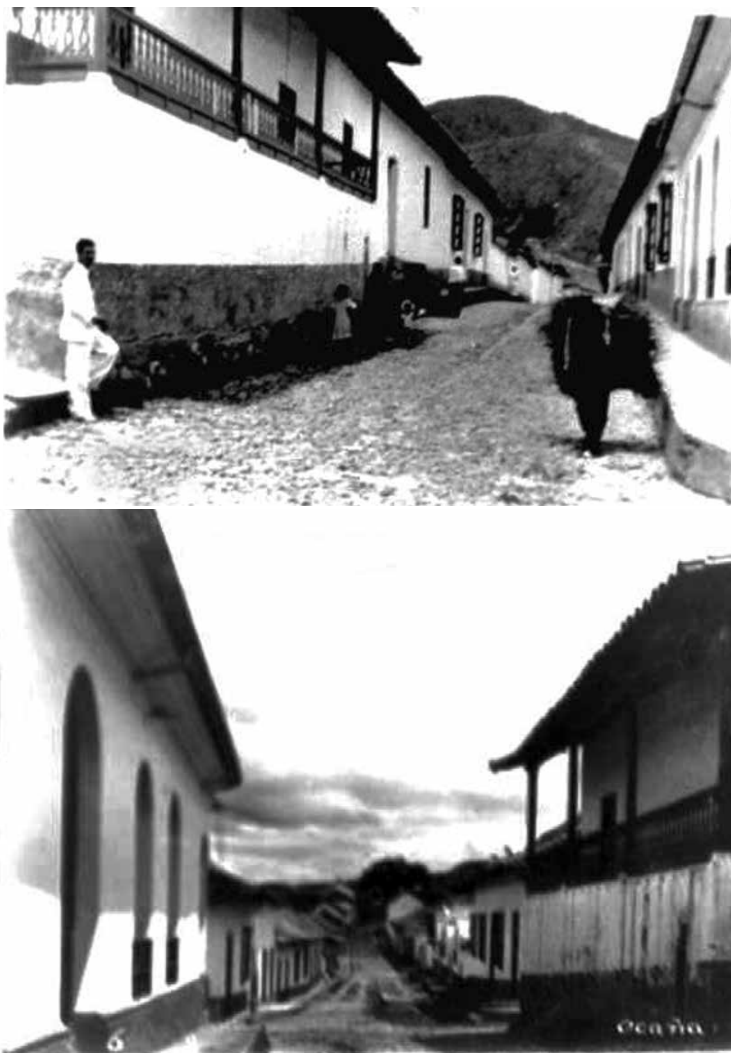
Figura 15. Parte posterior Colegio José Eusebio Caro, calle 10 antes de la construcción
