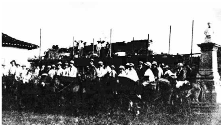
Figura 9. Inicios de la Construcción de la Planta Física
