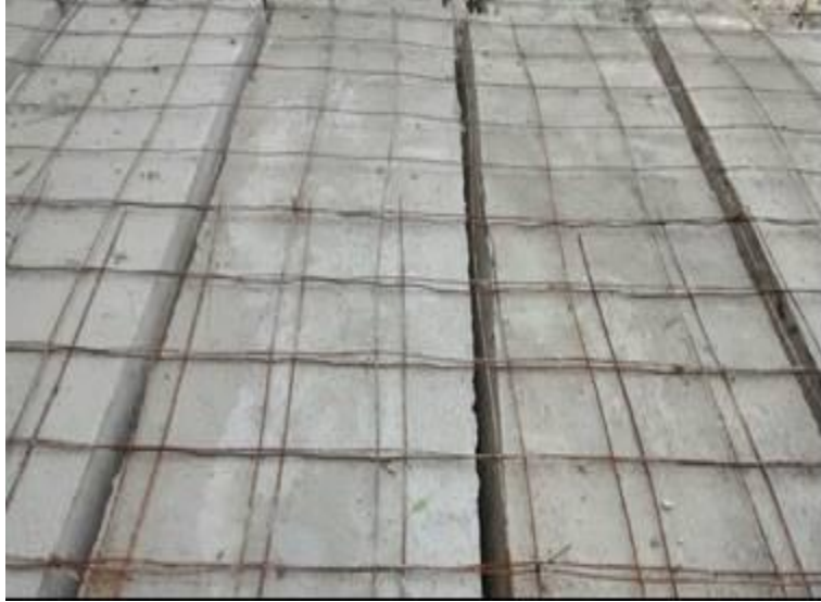
Figura 55. Ubicación de malla electro-soldada Fuente: Autores del proyecto
