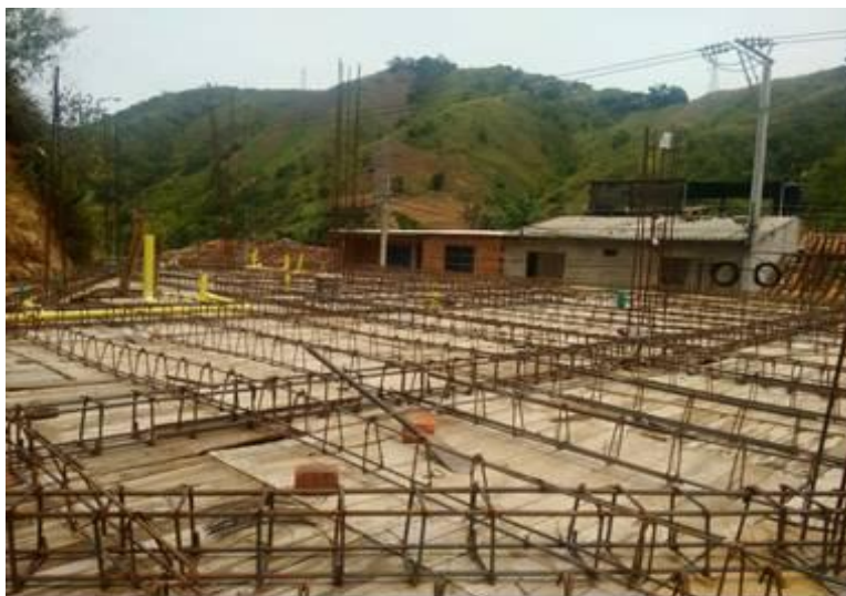
Figura 30. Acero de refuerzo de vigas y viguetas Fuente: autores del proyecto
