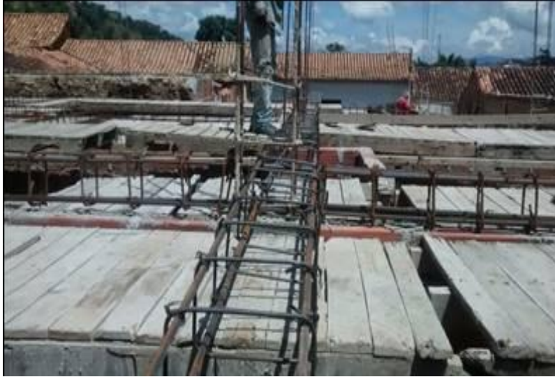
Figura 51. Instalación de acero de refuerzo Fuente: Autores del proyecto
