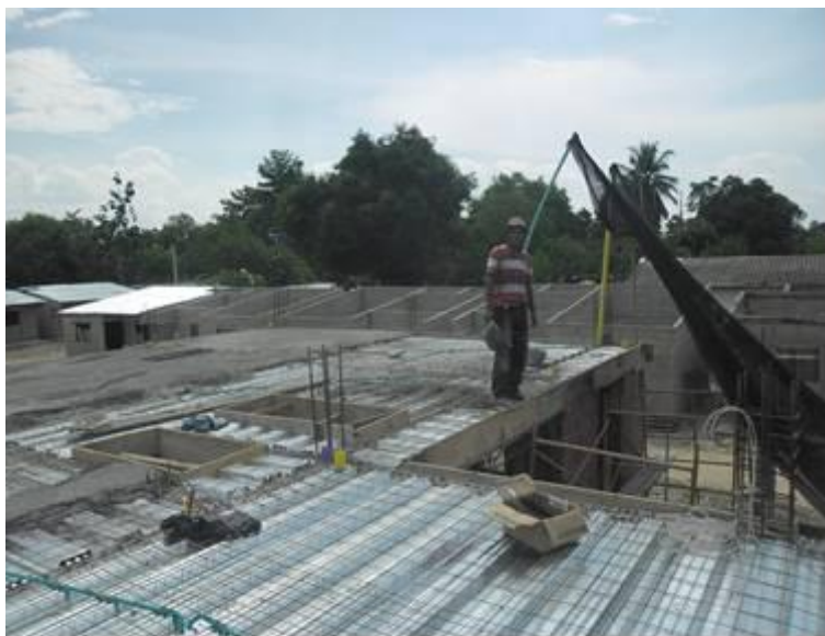
Figura 21. Instalación de la lámina de metal deck Fuente: Autores del proyecto
