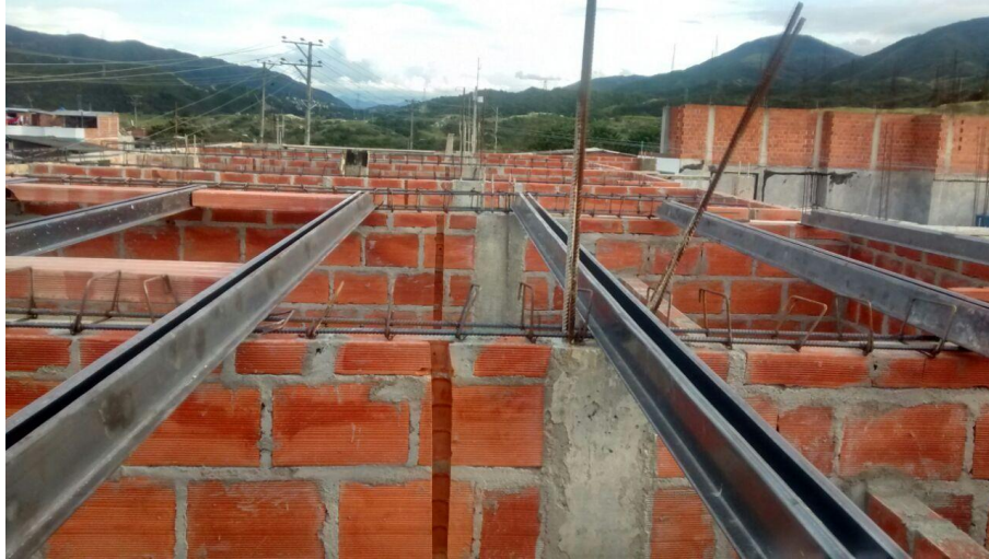
Figura 62. Ubicación de perfiles metalicos Fuente: Autores del proyecto
