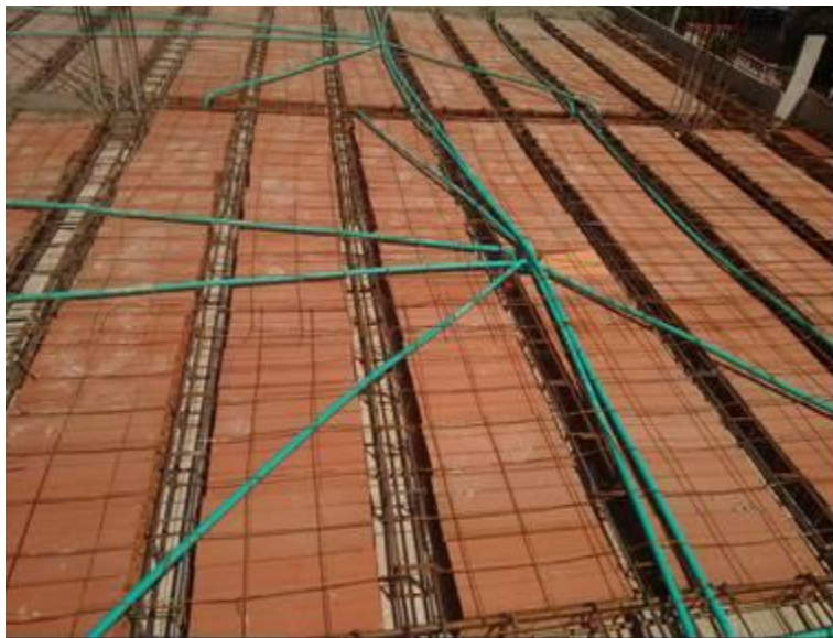
Figura 45. Instalación red eléctrica Fuente: Autores del proyecto
