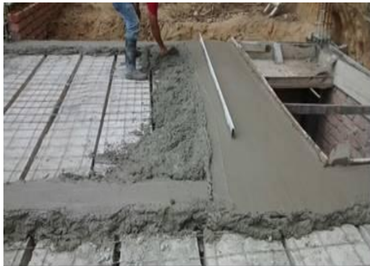
Figura 58. Vaciado de concreto
