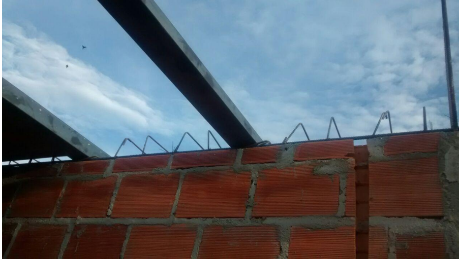
Figura 64. Instalacion de perfiles Fuente: Autores del proyecto
