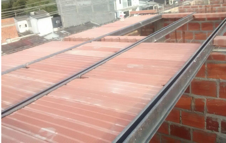
Figura 66. Instalacion de bloquelones Fuente: Autores del proyecto
