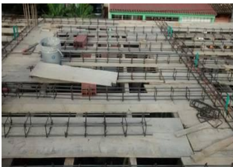
Figura 41. Instalación acero de refuerzo Fuente: Autores del proyecto
