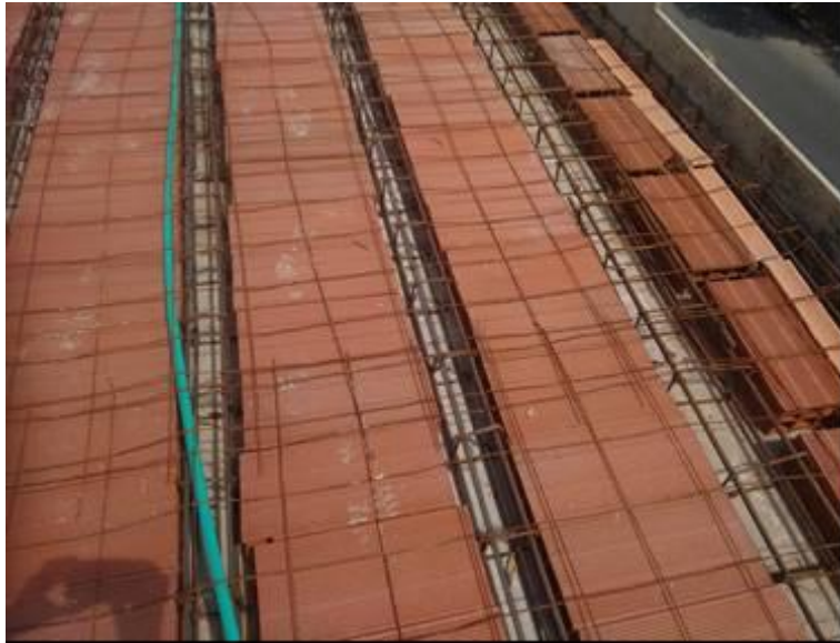
Figura 46. Instalación de malla electro soldada Fuente: Autores del proyecto
