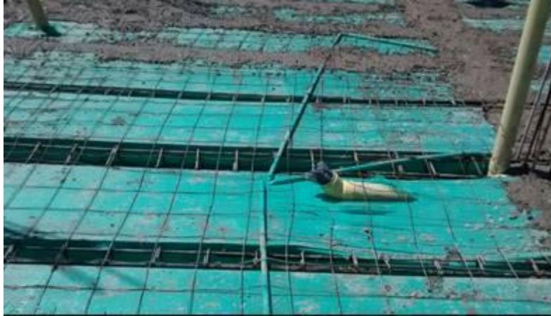
Figura 35. Instalacion de malla electrosoldada
