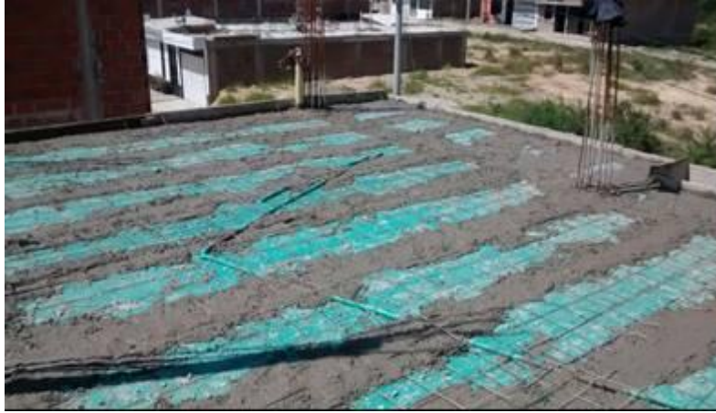
Figura 37. Vaciado del concreto Fuente: Autores del proyecto
