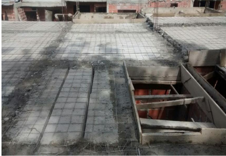
Figura 57. Vaciado de concreto vigas
