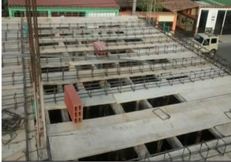
Figura 42. Instalación acero de refuerzo Fuente: Autores del proyecto
