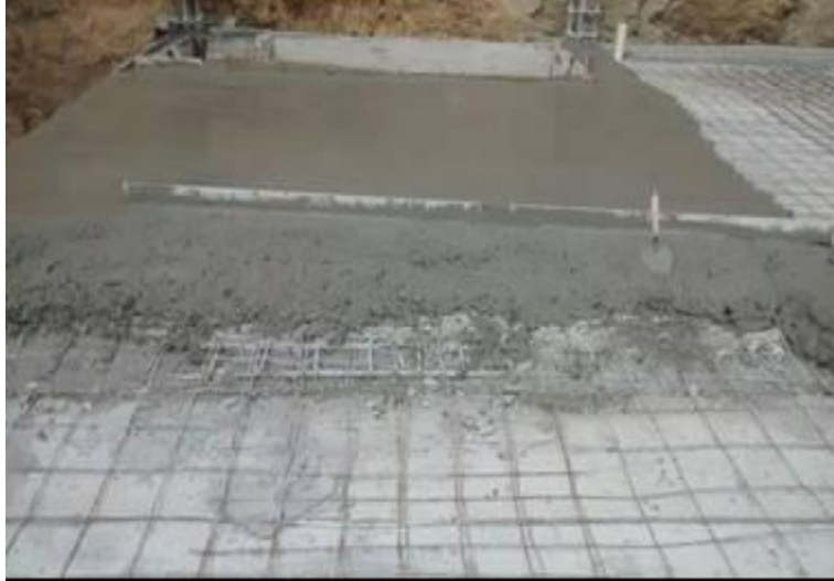
Figura 59. Vaciado de concreto Fuente: Autores del proyecto
