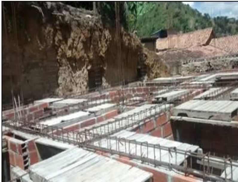
Figura 50. Instalación de acero de refuerzo Fuente: Autores del proyecto
