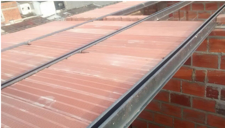
Figura 65. Instalacion de bloquelones Fuente: Autores del proyecto
