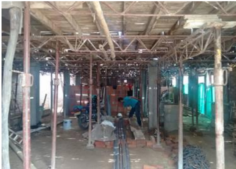
Figura 28. Ubicación de puntales losa de entresuelo con casetón
