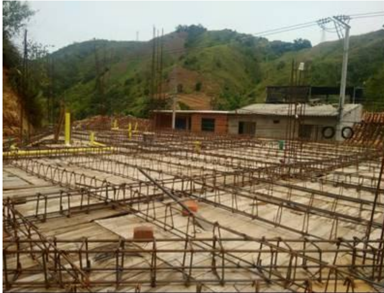
Figura 34. Instalación de tuberías hidráulicas y sanitarias Fuente: Autores del proyecto
