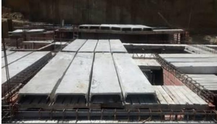
Figura 8. Losas de entrepiso con prefabricados
