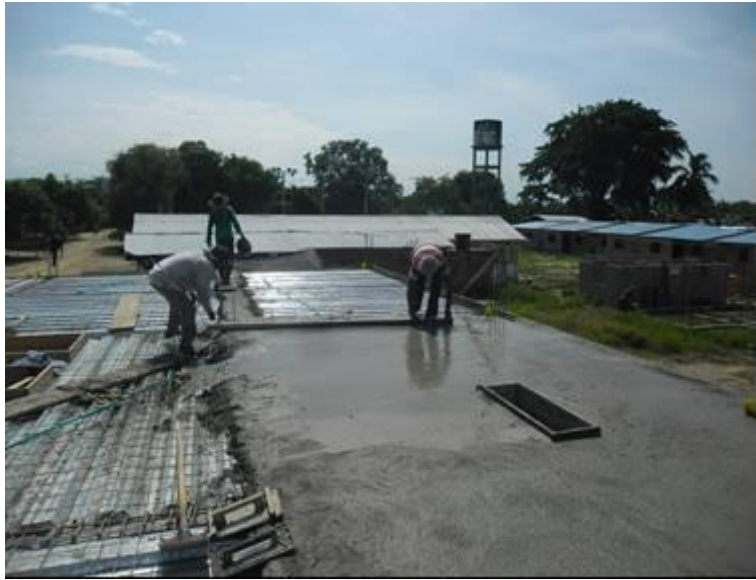
Figura 24. Vaciado del concreto Fuente: Autores del proyecto
