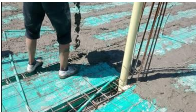
Figura 36. Vaciado del concreto
