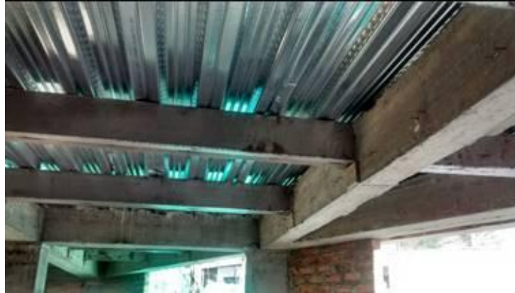
Figura 3. Losas de entrepiso con Metal Deck
