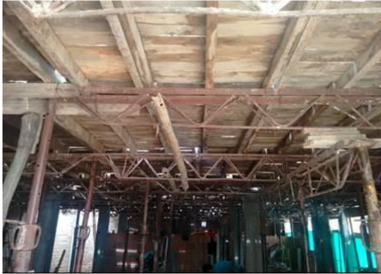
Figura 27. Encofrado de losa de entresuelo con casetón
