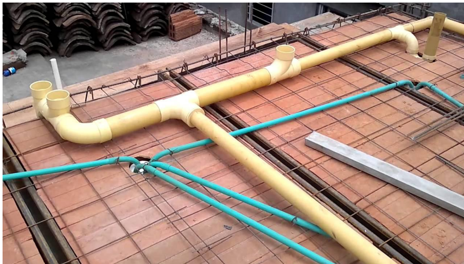
Figura 67. Instalacion de tuberías Fuente: Autores del proyecto
