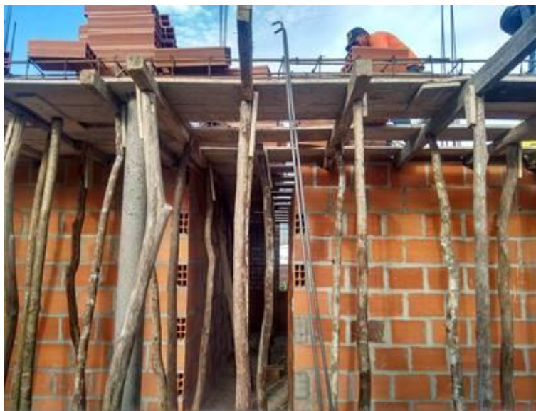
Figura 40. Ubicación de puntales Fuente: Autores del proyecto
