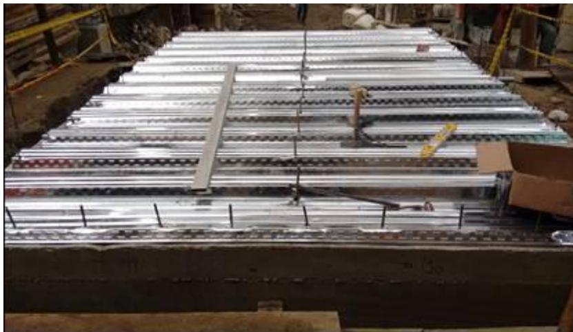
Figura 20. Instalación de la lámina de metal deck Fuente: Autores del proyecto
