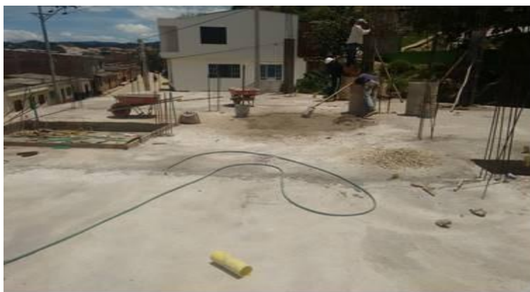
Figura 38. Curado del concreto Fuente: Autores del proyecto
