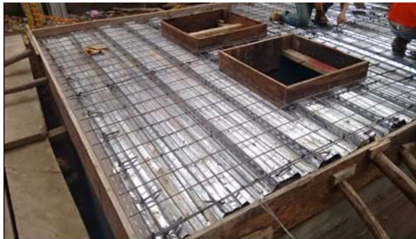
Figura 23. Instalación de la malla electro-soldada Fuente: Autores del proyecto
