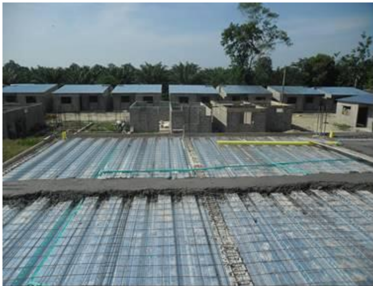
Figura 2. Losas de entrepiso con Metal Deck
