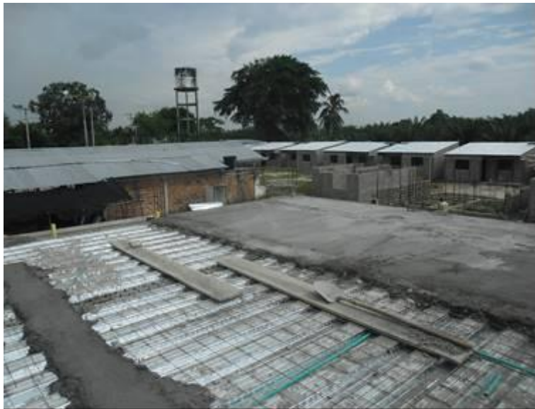
Figura 25. Vaciado del concreto Fuente: Autores del proyecto
