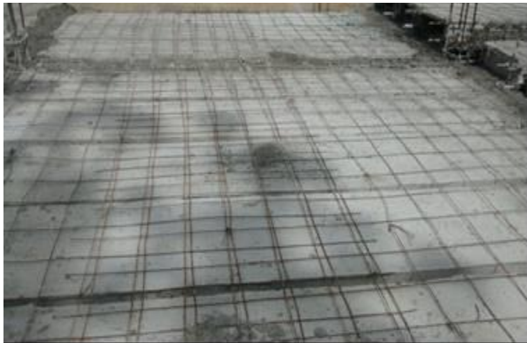
Figura 54. Ubicación de malla electro-soldada Fuente: Autores del proyecto
