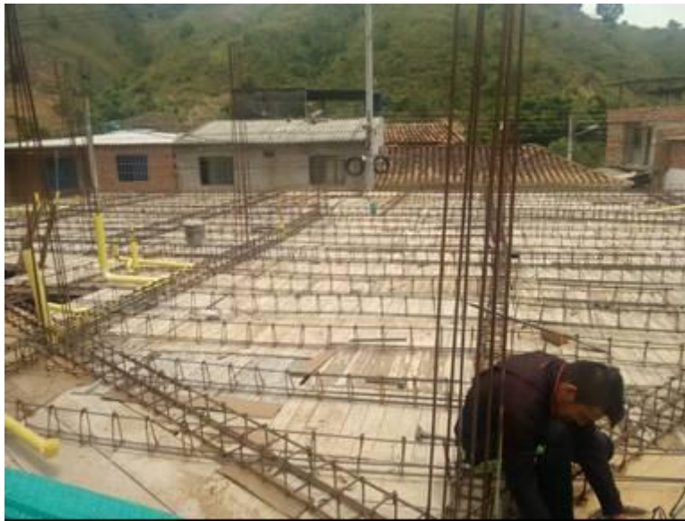
Figura 29. Acero de refuerzo de vigas y viguetas Fuente: autores del proyecto
