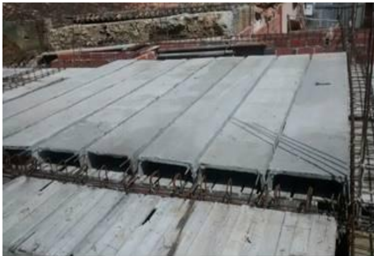
Figura 7. Losas de entrepiso con prefabricados
