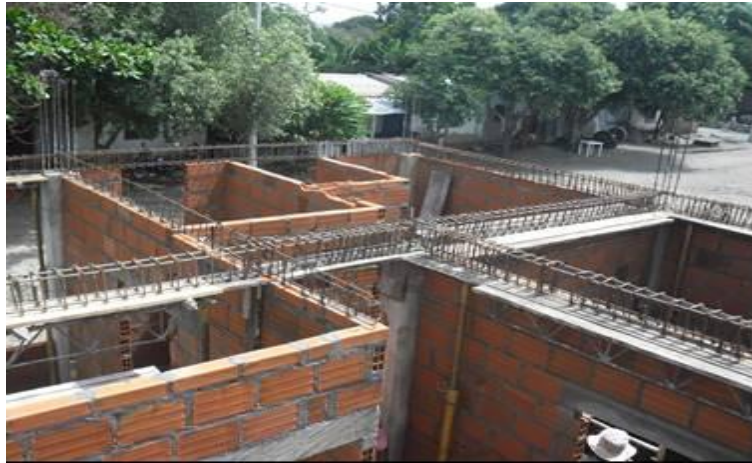
Figura 16. Instalación de acero de refuerzo de las vigas Fuente: Autores del proyecto
