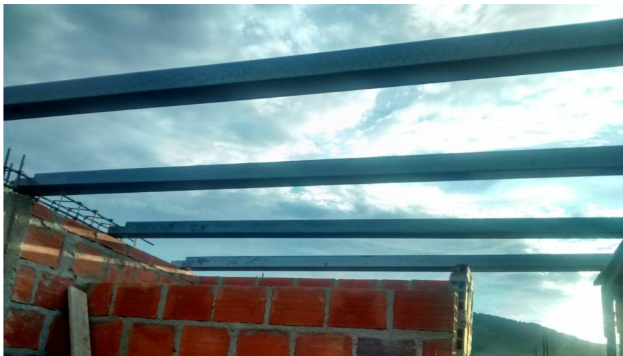
Figura 63. Ubicación de perfiles metalicos Fuente: Autores del proyecto
