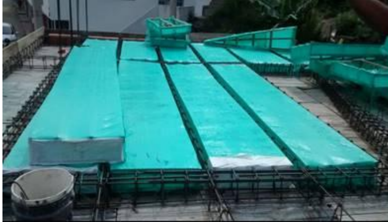
Figura 31. Ubicación de casetones de madera con lona
