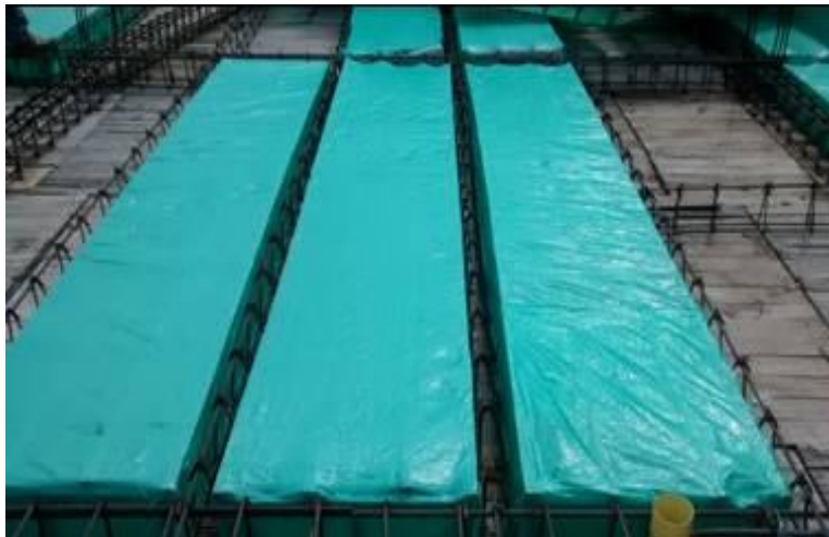
Figura 4. Losas de entrepiso aligerada con casetón
