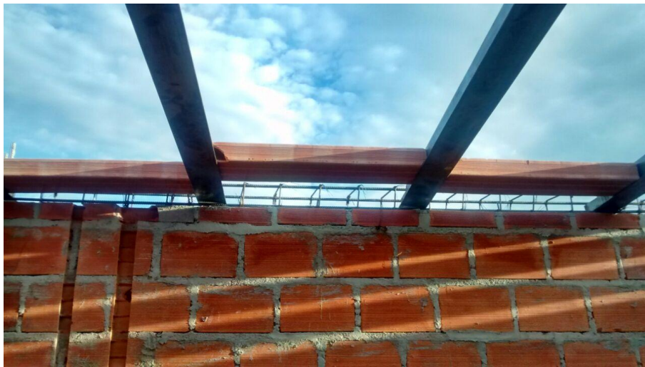
Figura 61. Muros de apoyo Fuente: Autores del proyecto
