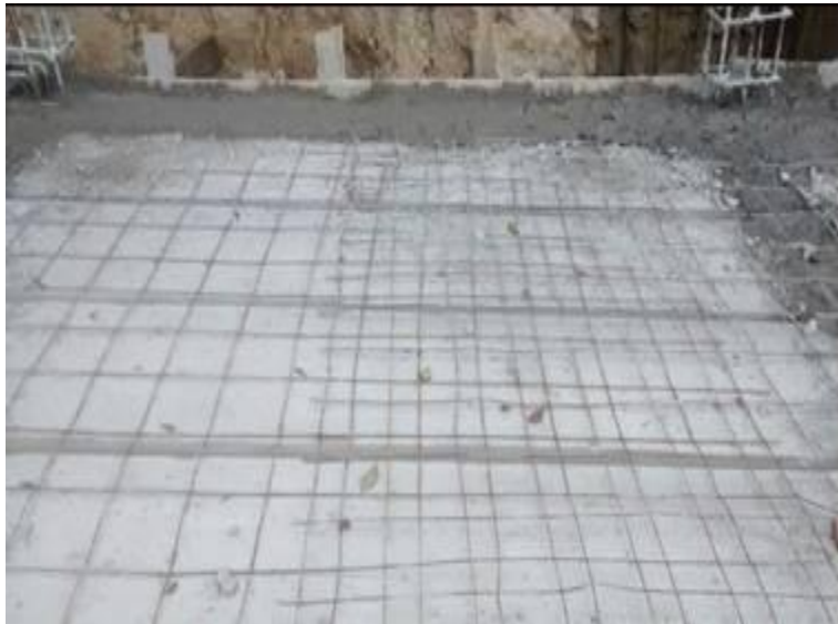
Figura 56. Vaciado de concreto vigas Fuente: Autores del proyecto
