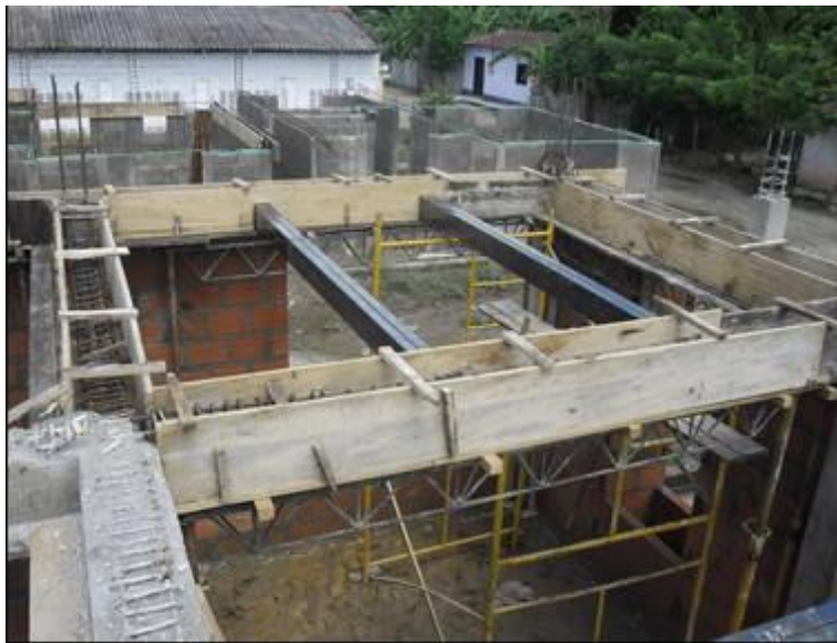
Figura 15. Encofrado de las vigas de carga
