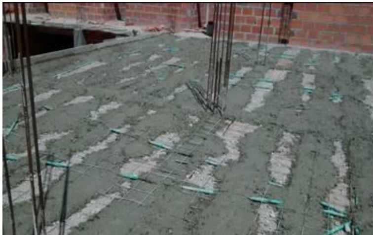
Figura 47. Vaciado de concreto Fuente: Autores del proyecto
