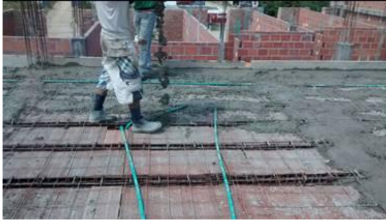
Figura 48. Vaciado de concreto Fuente: Autores del proyecto
