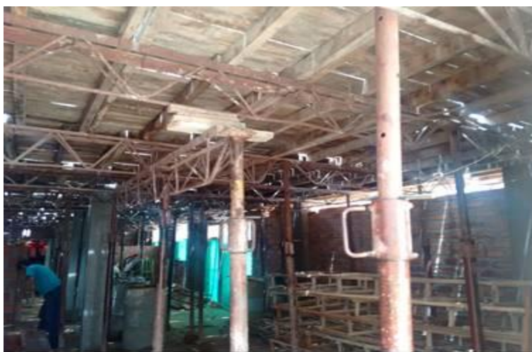
Figura 26. Encofrado de losa de entrepiso con casetón
