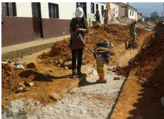
Figura 7. Relleno compactado con material seleccionado.
