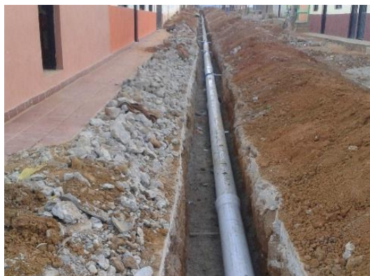
Figura 11. Suministro e instalación de tubería agua potable tipo PVC 6" y 10" RDE 21.
