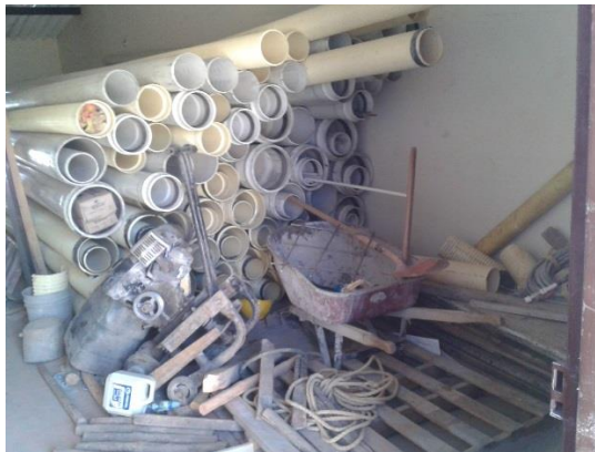
Figura 17. Almacenamiento de materiales en obra.
