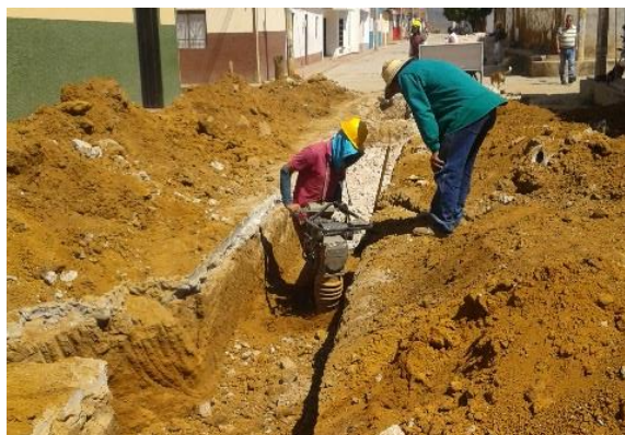
Figura 6. Relleno compactado con material de la misma excavación.
