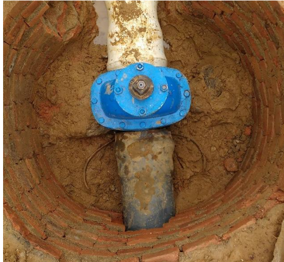
Figura 15. Instalación de válvulas de 10”.
