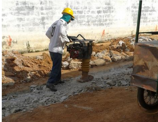
Figura 16. Verificación del equipo vibro compactador a utilizar en obra.
