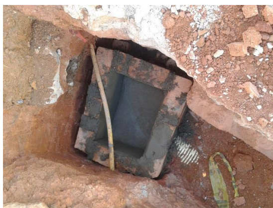
Figura 13. Caja de conexión domiciliaria de alcantarillado.
