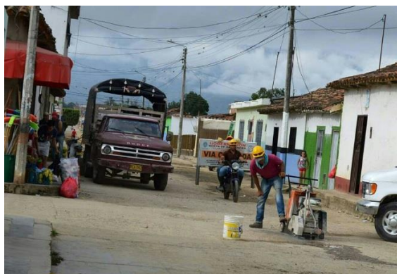
Figura 2. Demolición manual de pavimento rígido.
