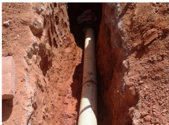
Figura 8. Tubería de PVC alcantarillado NOVAFORT D = 6" acometida.
