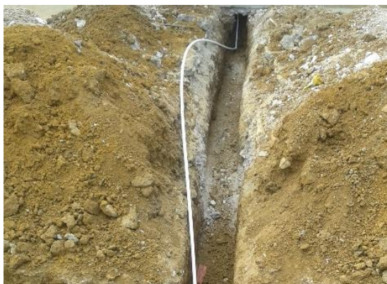
Figura 12. Suministro e instalación de acometida domiciliaria PVC 1/2" RDE 21.
