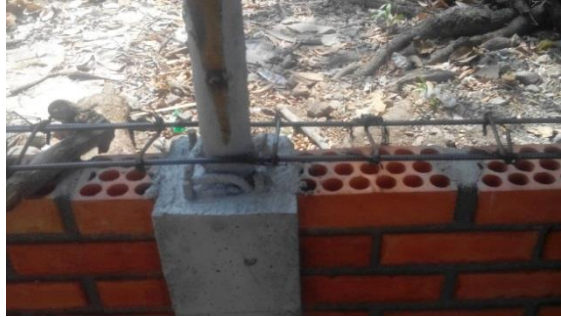
Figura 17. Figurado e instalación de acero de refuerzo para alfajía.
