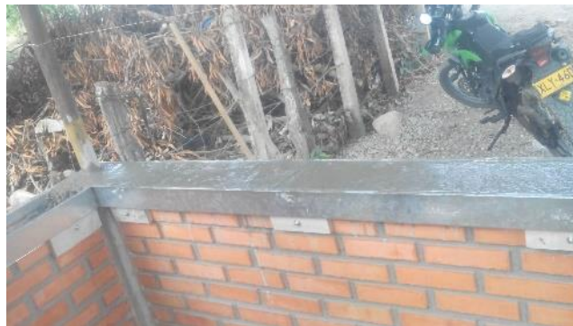
Figura 13. Fundición de alfajía en concreto de 3000 psi. Fuente: Autores del Proyecto, 2016.
