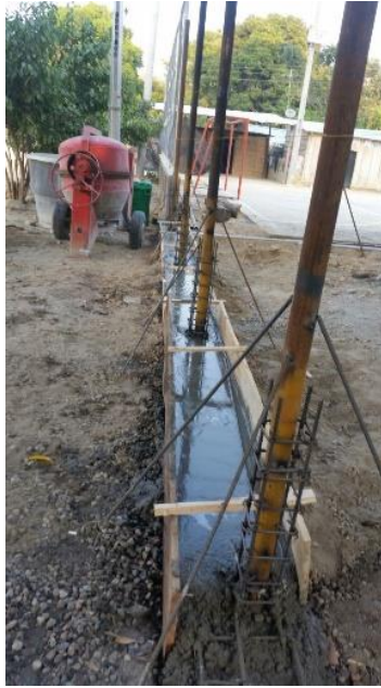
Figura 11. Fundición de viga cimiento en concreto de 3000 psi. Fuente: Autores del Proyecto, 2016.
