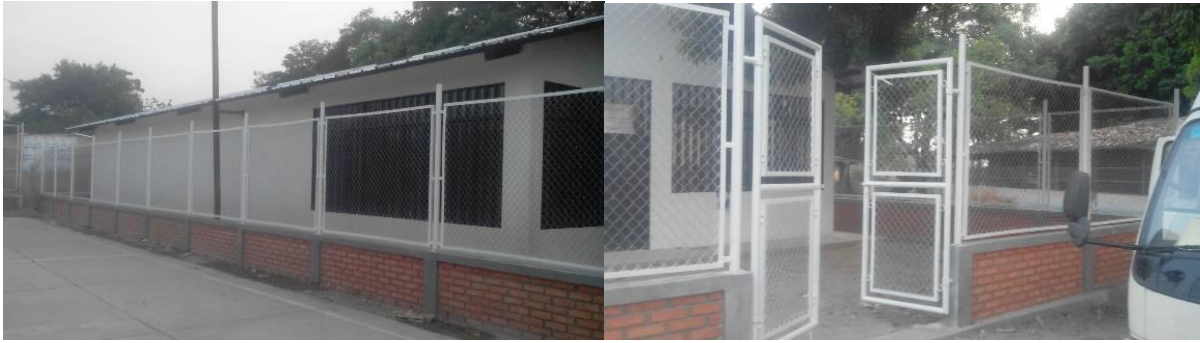
Figura 20. Cerramiento en malla eslabonada.
