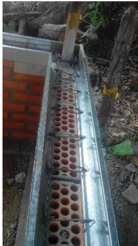
Figura 8. Encofrado de alfajía (0,2 Mts x 0,10 Mts). Fuente: Autores del Proyecto, 2016.
