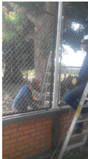
Figura 19. Suministro e instalación de módulo de malla eslabonada.
