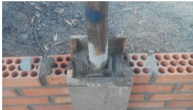
Figura 12. Fundición de columna en concreto de 3000 psi. Fuente: Autores del Proyecto, 2016.
