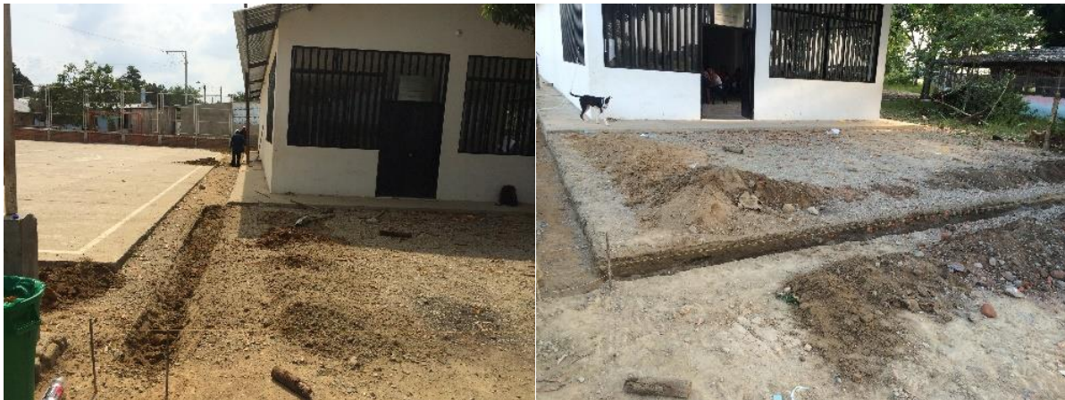
Figura 5. Cortes y Excavaciones. Fuente: Autores del Proyecto, 2016.
