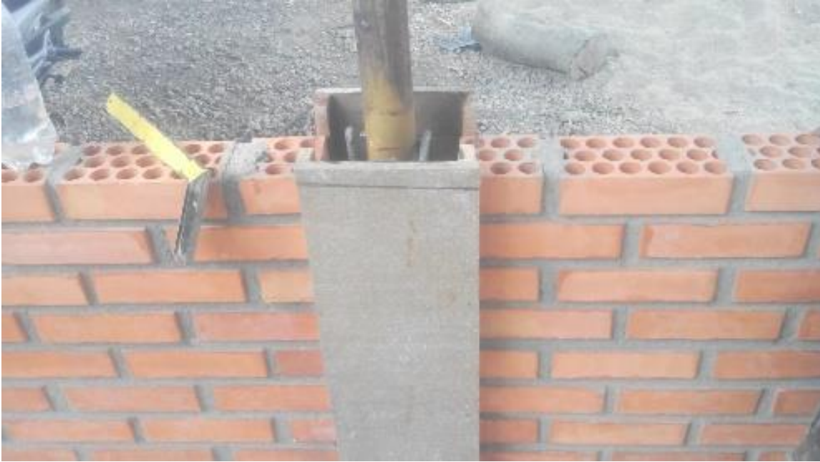
Figura 7. Encofrado de columnas (0,2 Mts x 0,20 Mts). Fuente: Autores del Proyecto, 2016.
