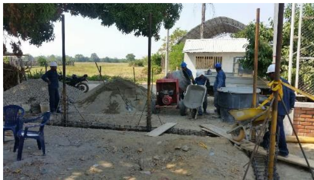
Figura 10. Preparación del concreto de 3000 psi. Fuente: Autores del Proyecto, 2016.
