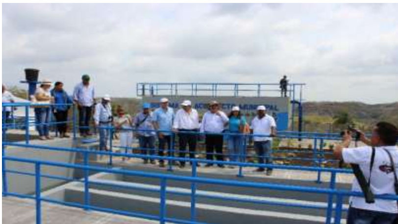
Figura 1 Planta de tratamiento.
