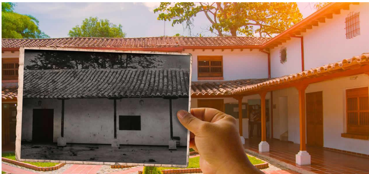
Figura 2. Instalaciones Administrativas UFPSO
