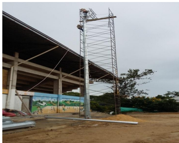
FOTO 12 TRABAJO EN ALTURAS CON EQUIPO DE PROTECCION PERSONAL
