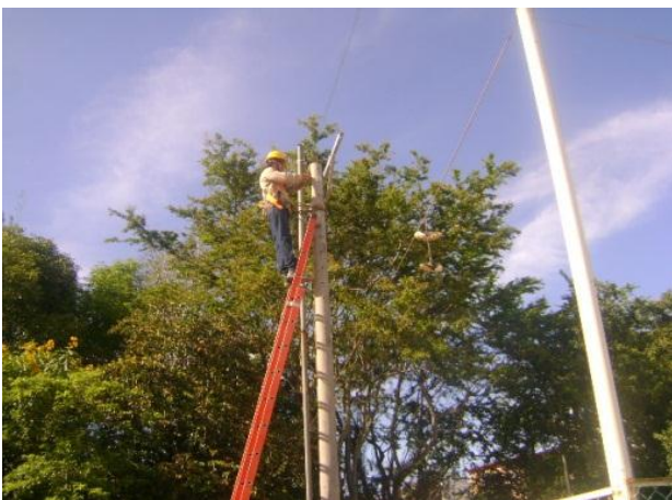
FOTO 9 TRABAJO EN ALTURAS CON ESCALERA
