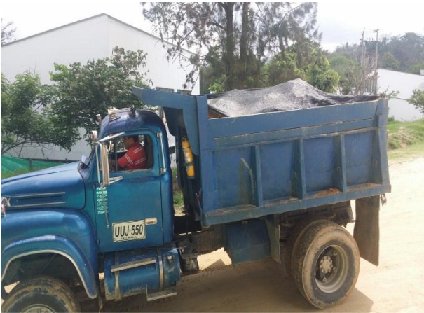
FOTO 7 RETIRO Y TRANSPORTE DE MATERIAL CUBIERTO
