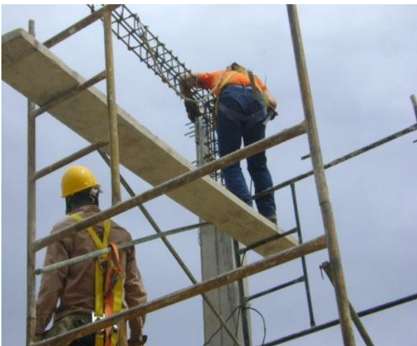
FOTO 11 TRABAJO EN ALTURAS CON EQUIPOS DE PROTECCION PERSONAL
