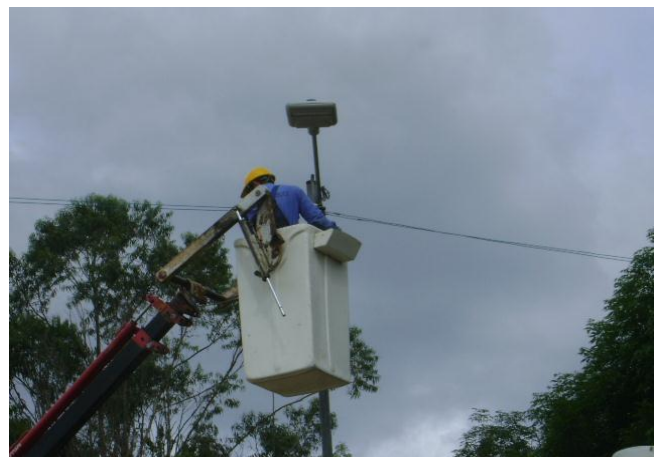
FOTO 10 TRABAJO EN ALTURAS CON CANASTILLA
