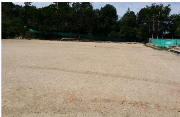
FOTO 5 CERRAMIENTO PERIMETRAL EN TELA VERDE
