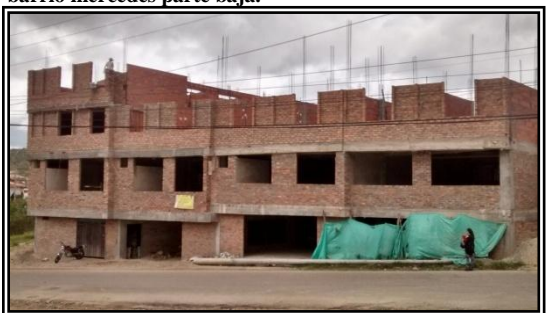
Figura 9. Edificación de 4 pisos, bodega y residencia san francisco, barrio acolsure
