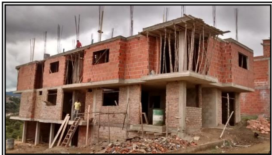
Figura 6. Edificación de 4 pisos, manzana 4 lote 17. Urb. monte lago.
