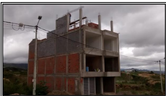
Figura 4. Edificación de 4 pisos, Urb. monte lago.
