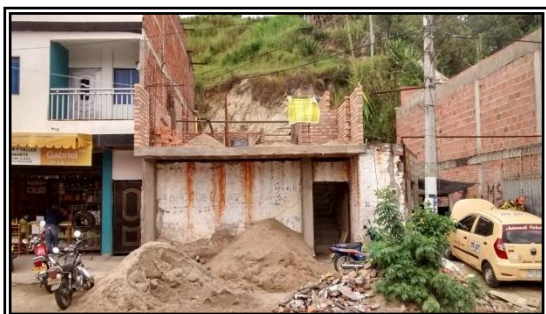
Figura 7. Edificación de 2 pisos, carrera 10 # 14 – 36 barrio mercedes parte baja.
