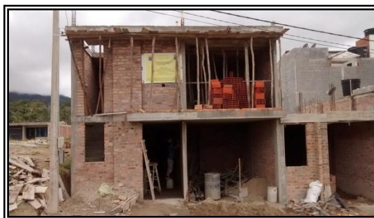
Figura 3. Edificación de 2 pisos, Urb. monte lago.
