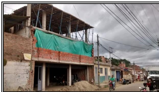
Figura 5. Edificación de 3 pisos, calle 2 # 15 -20 barrio Juan XXXIII.
