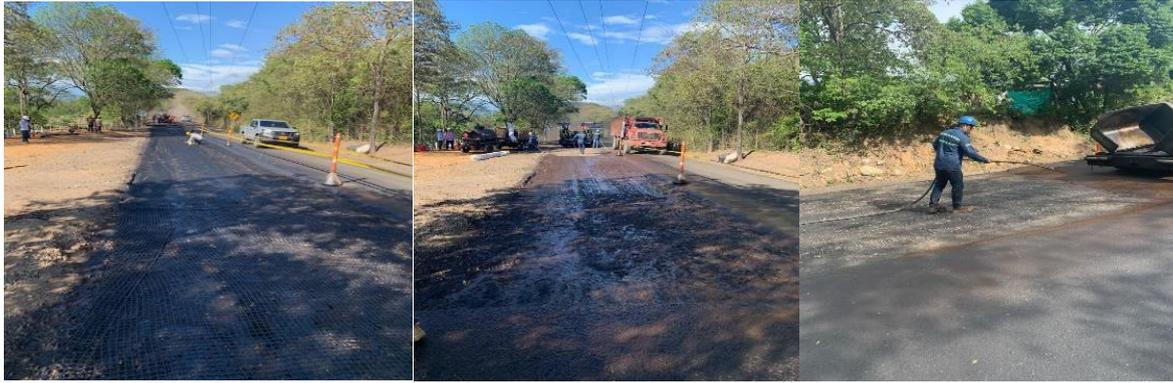
*Figura 23.* Imprimación con emulsión asfáltica CRL -1 y riego de liga. Fuente: Consorcio Vías Nacionales, 2020.
