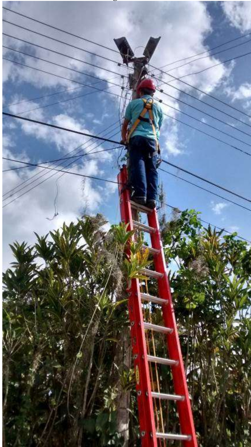
Revisión Acometidas Eléctricas Parqueadero Casona Fotografía N° 28
