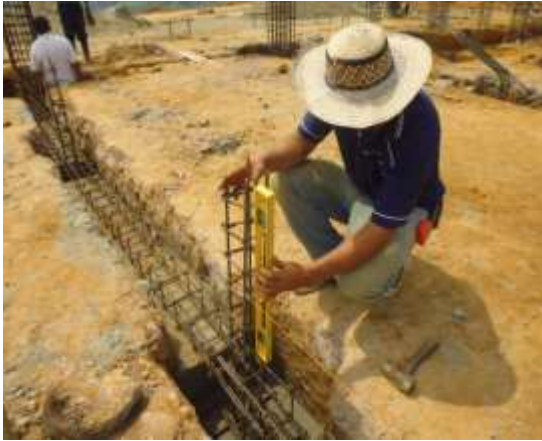
Fotografía 30. Nivel vigas de amarre
