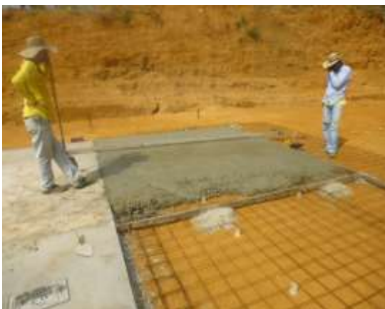
Fotografía 36. Refuerzo y fundido de losa
