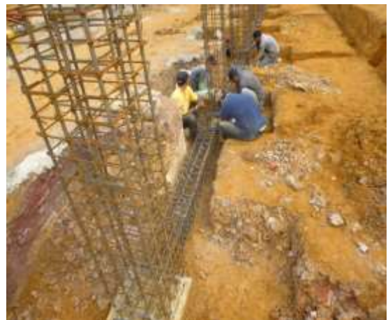
Fotografía 29. Colocación de refuerzo
