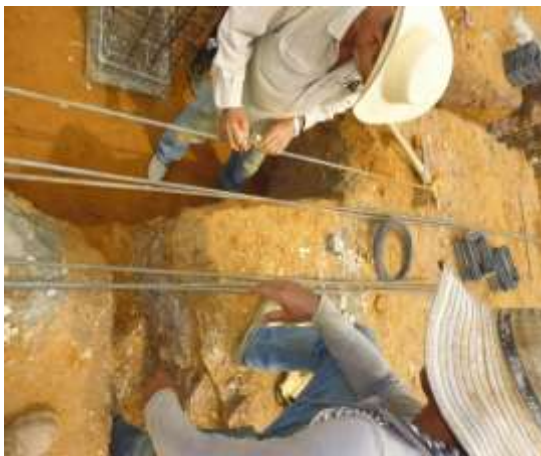
Fotografía 28. Medición de vigas
