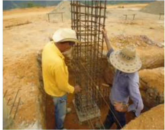
Fotografía 35. Marcación de guías
