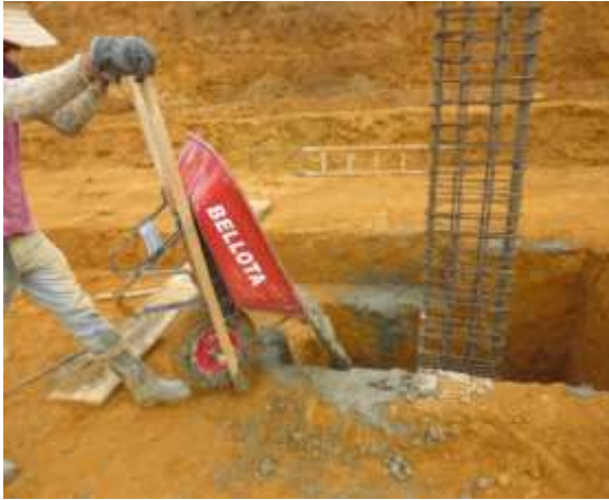
Fotografía 20. Vertimiento de concreto
