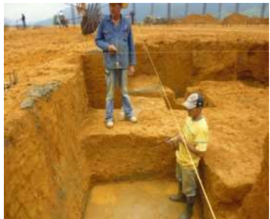
Fotografía 8. Excavación. Zapatas
