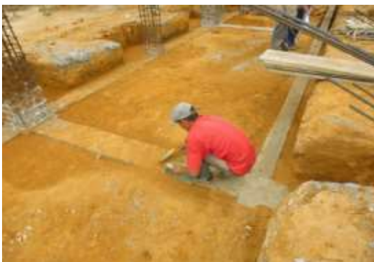
Fotografía 39. Limpieza de la fundición
