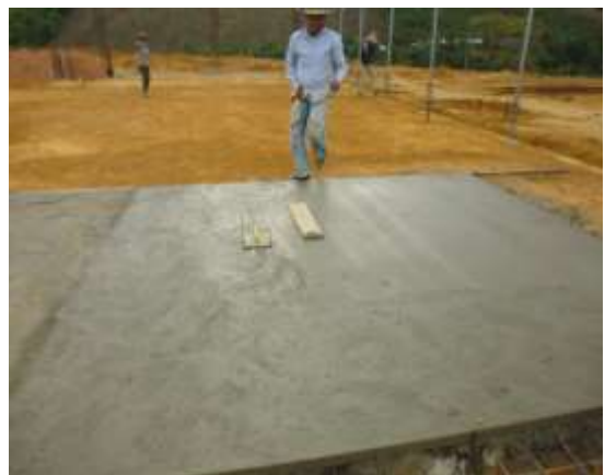
Fotografía 37. Refuerzo y fundido de losa
