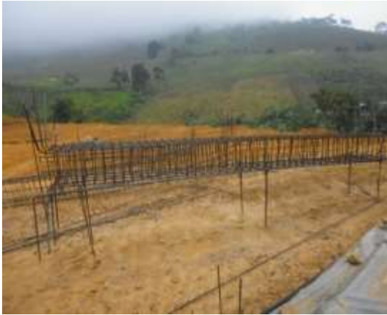
Fotografía 34. Armado de refuerzo
