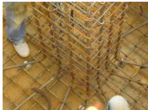
Fotografía 17. Refuerzo de pedestal
