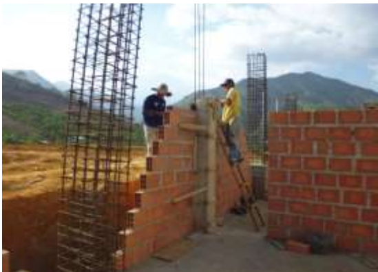
Fotografía 46. Colocación de formaletas
