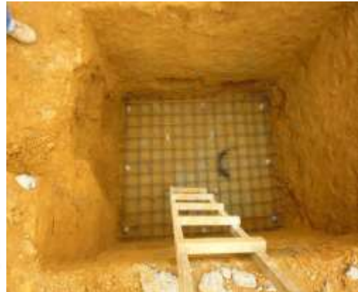
Fotografía 15. Refuerzo zapata
