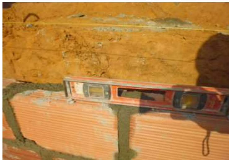
Fotografía 43. Toma de nivel
