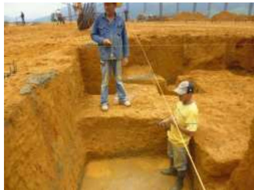
Fotografía 11. Traslado de ejes
