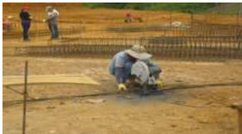
Fotografía 14. Obrero cortando acero
