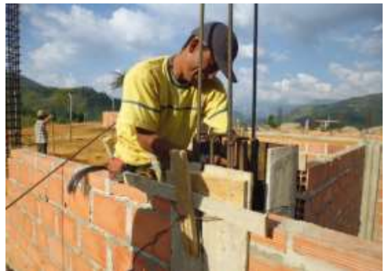
Fotografía 47. Colocación de formaletas
