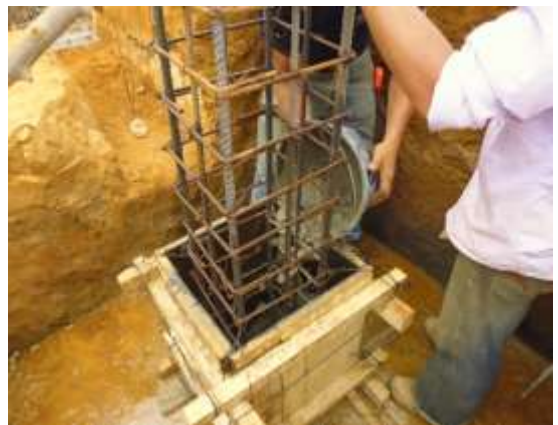
Fotografía 22. Vaciado pedestal
