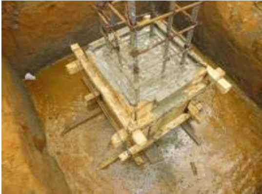
Fotografía 23. Vaciado completo
