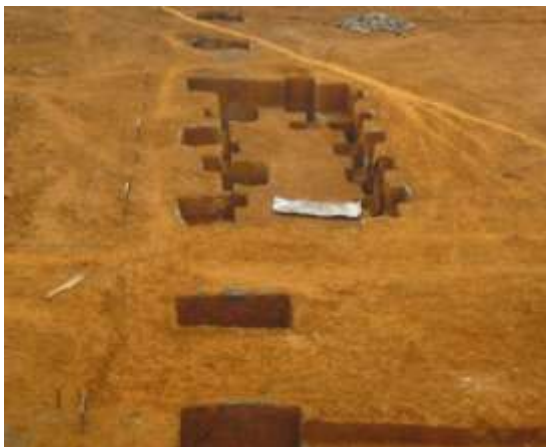
Fotografía 7. Excavación área de oficinas
