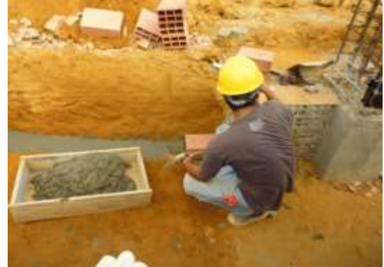
Fotografía 42. Colocación de mortero
