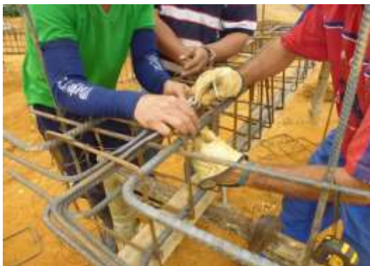
Fotografía 16. Estribos de pedestal
