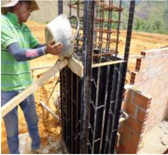
Fotografía 52. Vaciado
