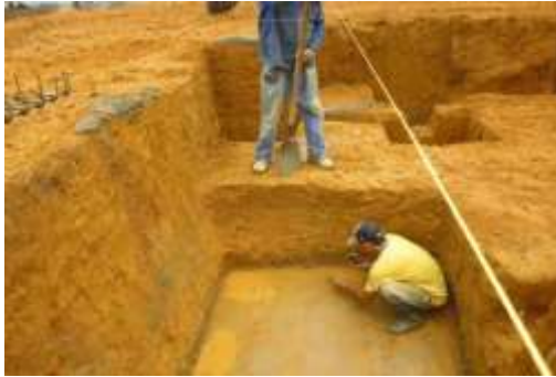
Fotografía 12. Traslado de ejes
