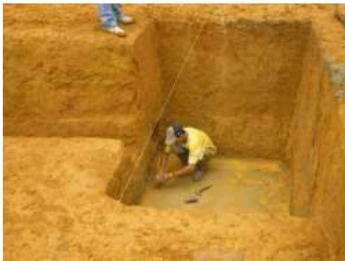
Fotografía 10. Traslado de ejes
