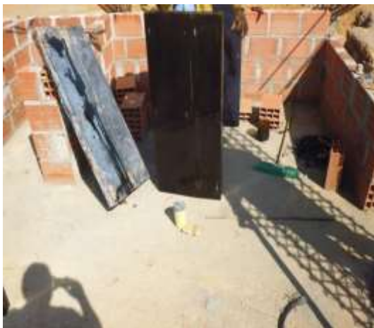
Fotografía 50. Formaleta metálica
