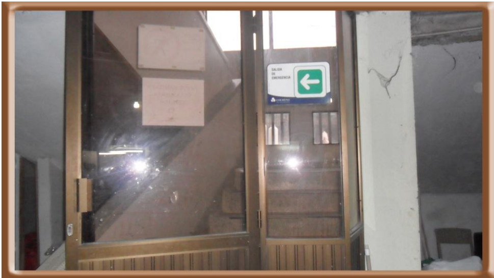
Foto EF005: Salidas de Emergencias
