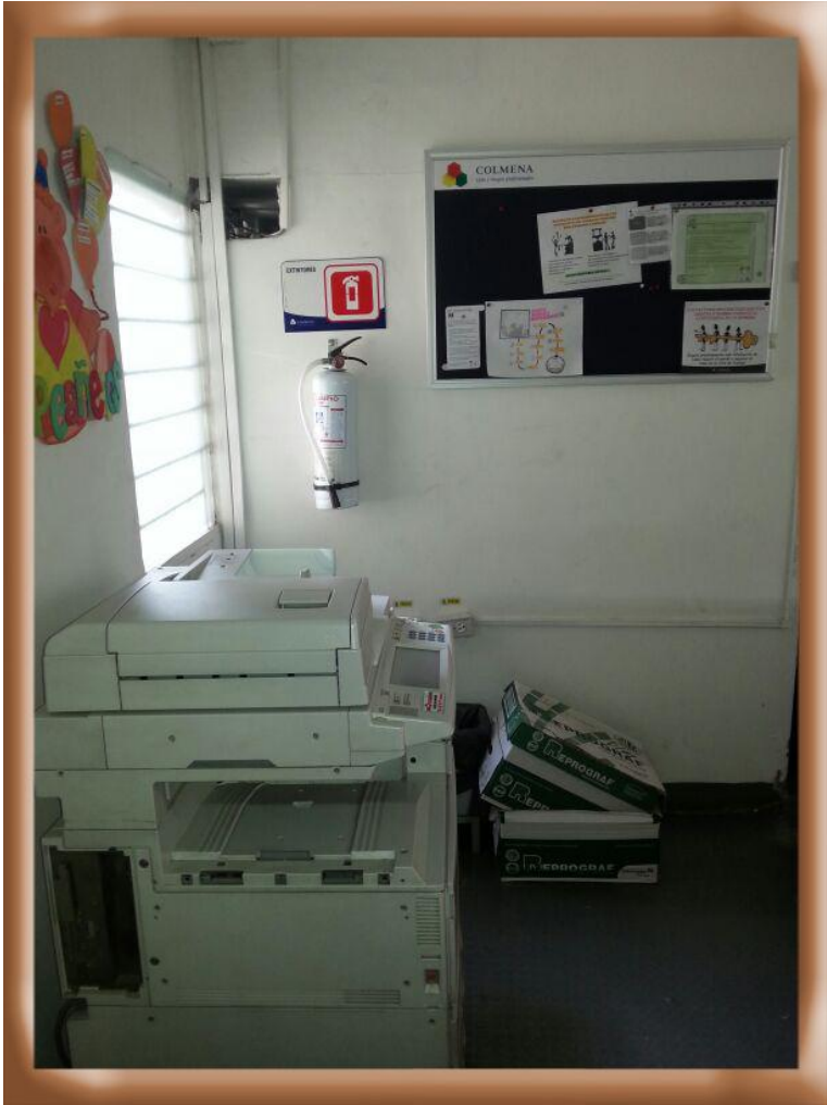
Foto 6. Extintor 3. Primer Piso.
