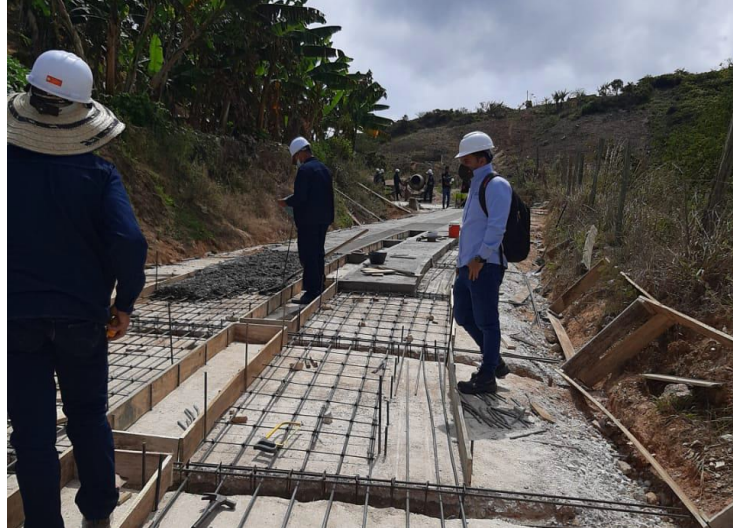
Figura 3. Revisión armada del acero (Diámetro, separación y empalmes). Autores 2022
