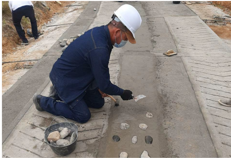
Figura 6. Instalación de piedra pegada. Autores 2022
