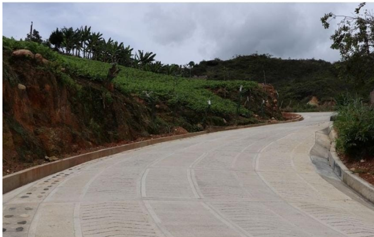
Figura 7. Terminación del tramo de placa huella corredor Quebrada la Esperanza - Cerro de las Flores (Municipio de Ocaña). Autores 2022
