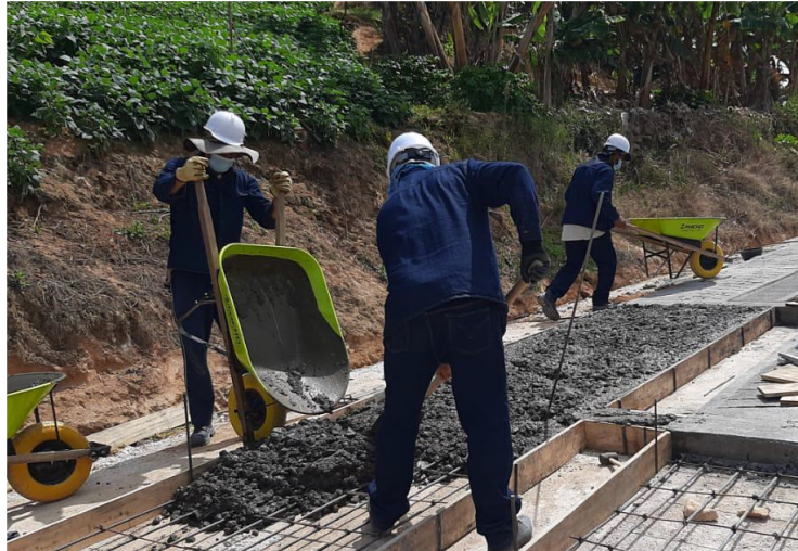
Figura 4. Elaboración, transporte, colocación, vibrado y curado del concreto. Autores 2022
