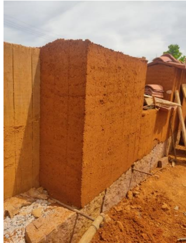
Figura 29. Inspección visual del muro. Figura 30. Desencofrado del tapial y muro.
