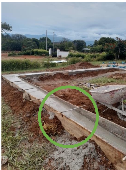
Figura 5. Cimentación en Concreto ciclópeo.
