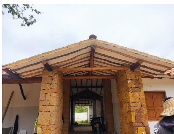
Figura 41. Cubierta terminada con tejar.
