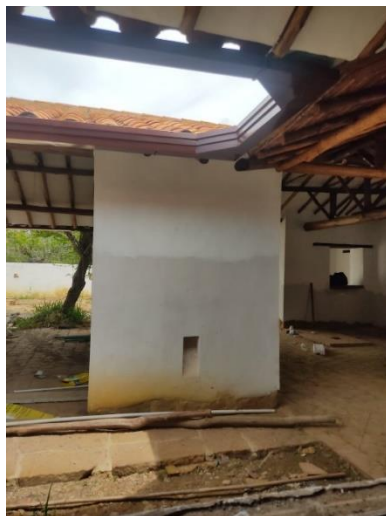
Figura 46. Aplicado de cal en muro.
