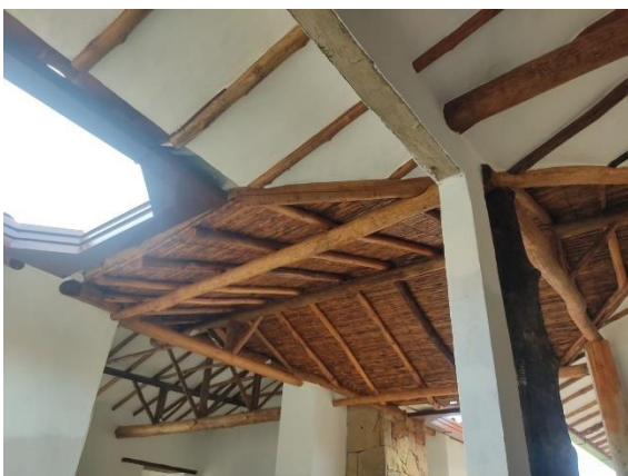
Figura 40. Cubierta con tablonces de madera.
