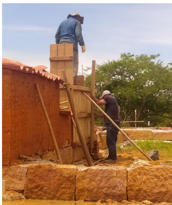
Figura 20. Mano de obra en la tapia pisada.
