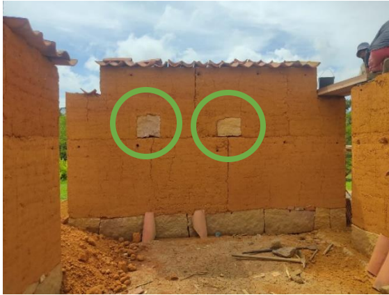
Figura 22. Piedra entre tramos de muro.
