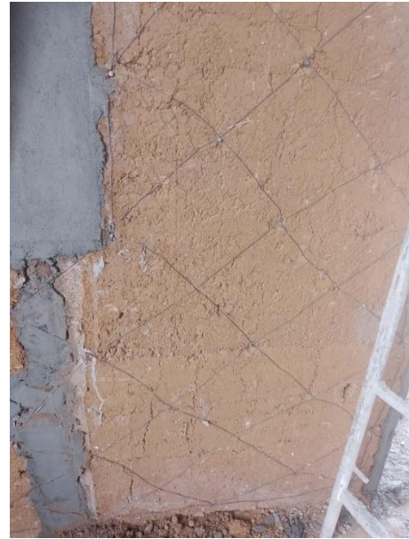
Figura 45. Pañete de muros en tapia pisada.
