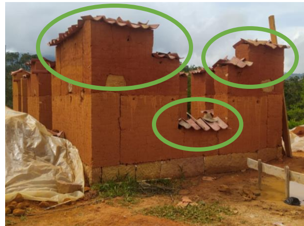
Figura 32. Protección de muro en tapia pisada.
