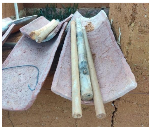
Figura 27. Latas de madera como refuerzo.
