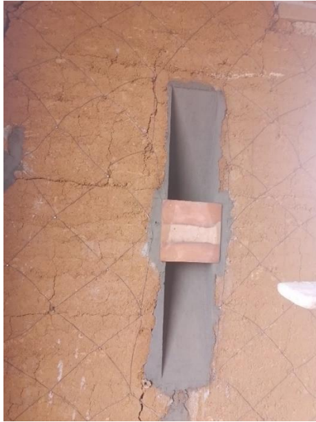
Figura 44. Malla con puntales y alambre.
