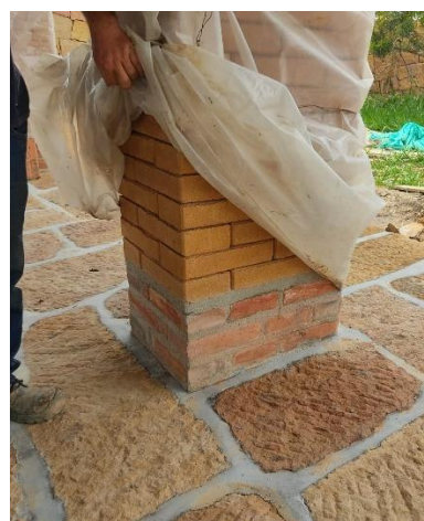
Figura 10. Sobrecimiento en ladrillo a la vista.
