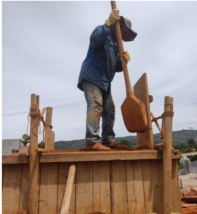
Figura 21. Apisonamiento de la tapia.
