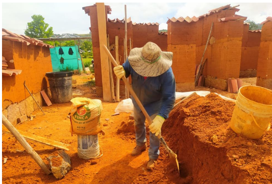
Figura 16. Manipulación de la tapia.
