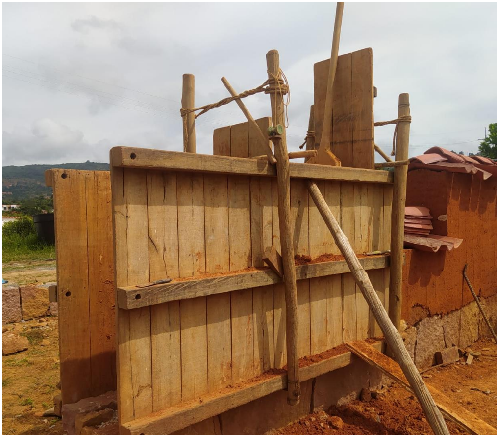
Figura 11. Tapial armado.
