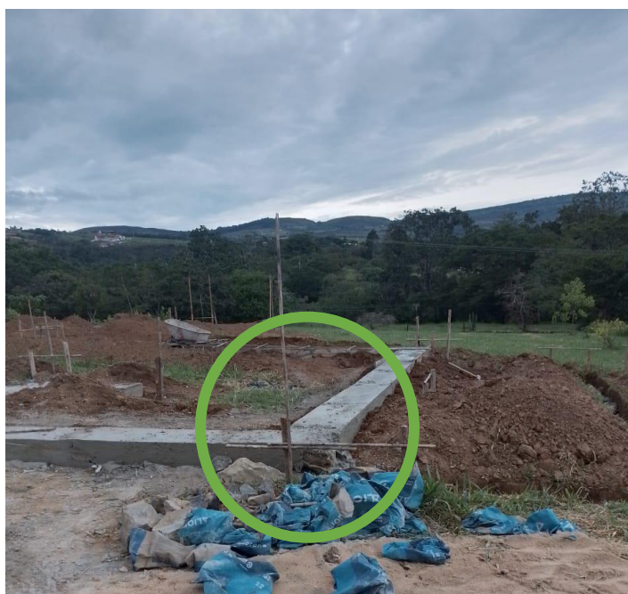
Figura 6. Cimentación en Concreto reforzado.
