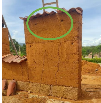
Figura 23. Orificios para apoyo de tornillos.
