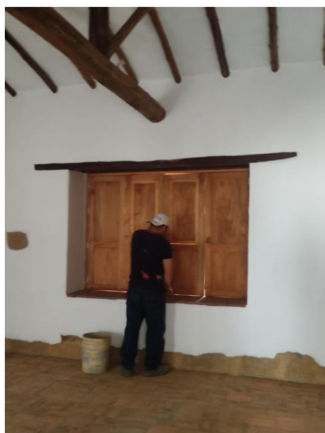
Figura 48. Ventana en madera.
