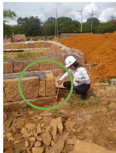
Figura 8. Inspección del sobrecimiento.
