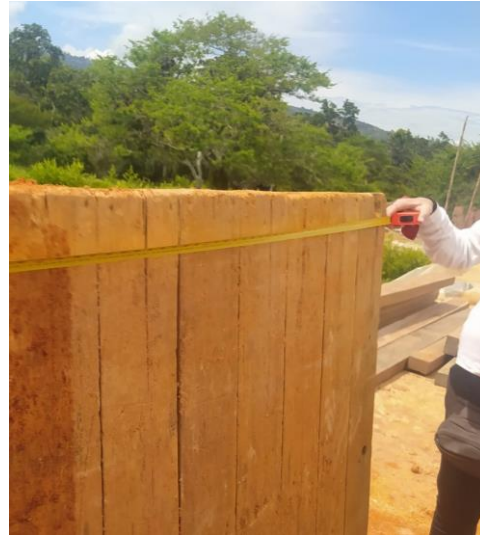
Figura 13. Medidas a los tableros.
