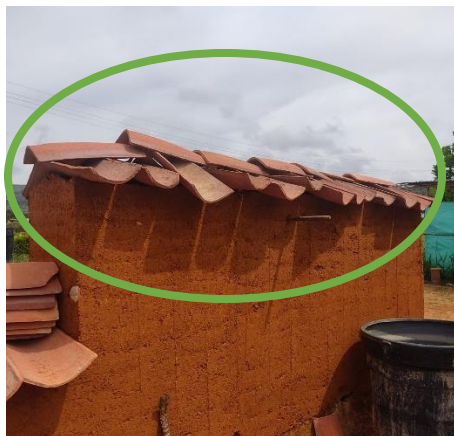
Figura 31. Tejas sobre muro en tapia.
