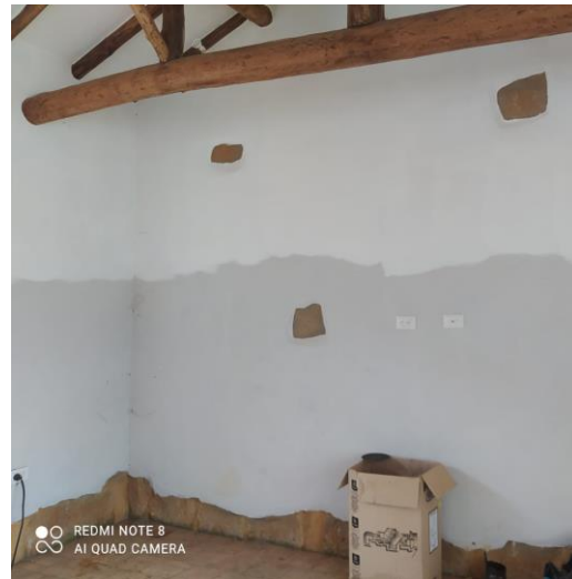
Figura 47. Aplicado de pintura en el muro.
