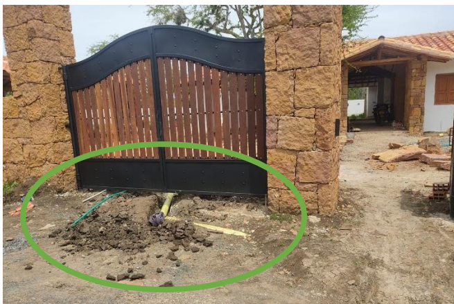
Figura 43. Instalaciones eléctricas y sanitarias en PVC.
