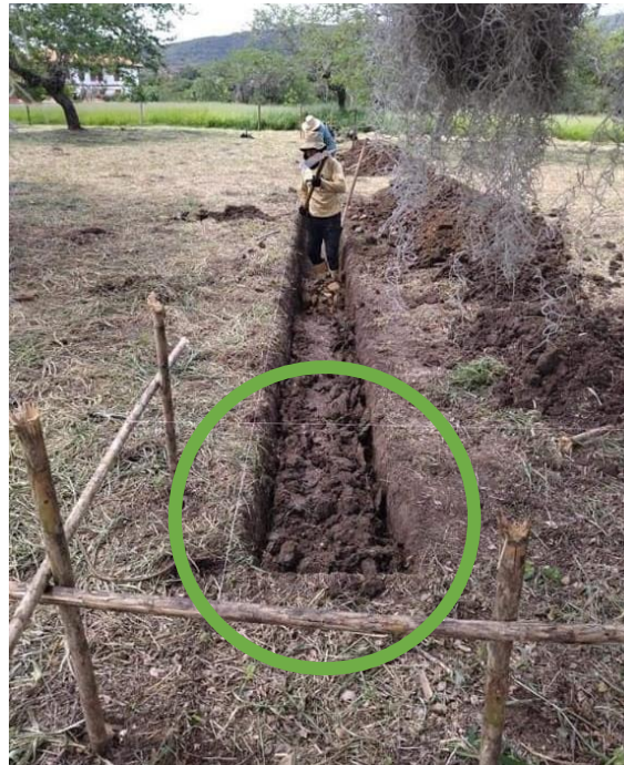
Figura 3. Excavaciones de 50 cm de profundidad.
