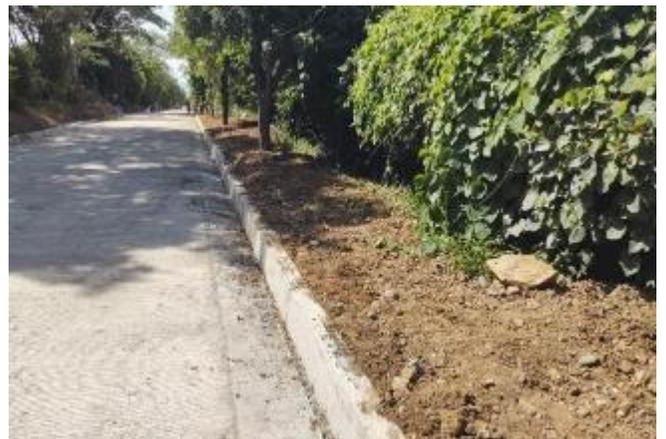
Instalación de bordillo en concreto
