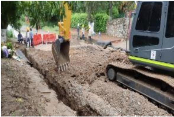
Excavación de la explanación a máquina.
