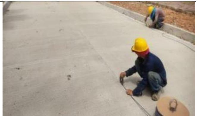
Fisura inducida , junta de dilatación el poliuretano
