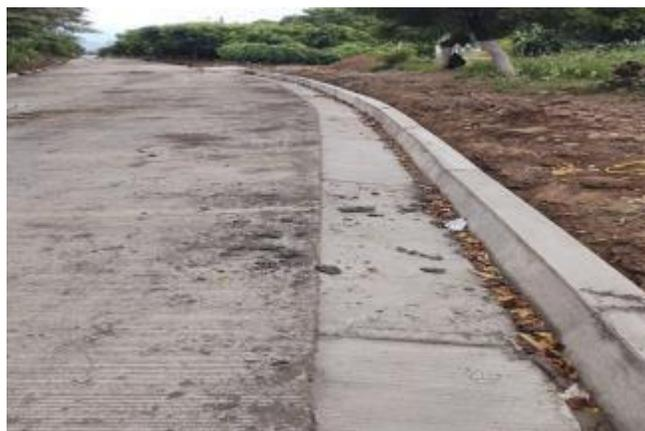
Instalación de bordillo en concreto
