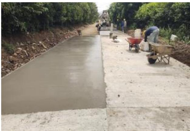
Instalación de pavimento en concreto hiraúlico
