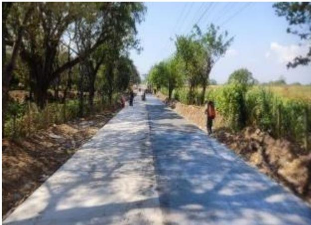
Instalación de pavimento en concreto hidráulico
