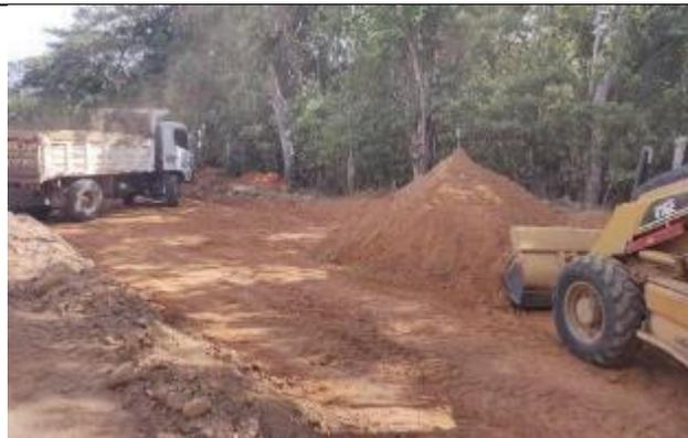
Excavación de la explanación a máquina .
