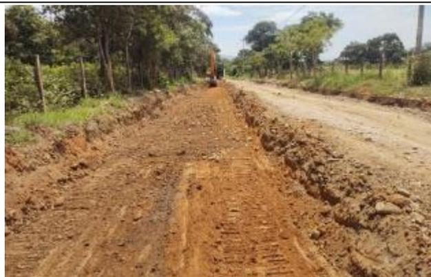
Excavación de la explanación a máquina .
