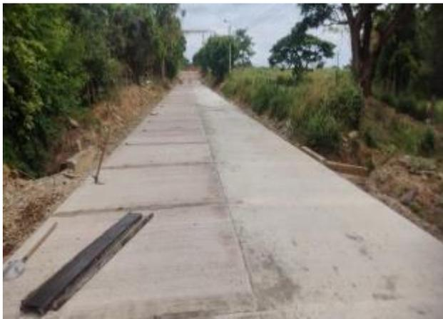
Instalación de pavimento en concreto hidráulico
