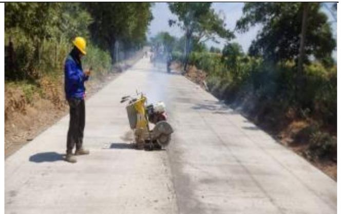
Fisura inducida , junta de dilatación el poliuretano
