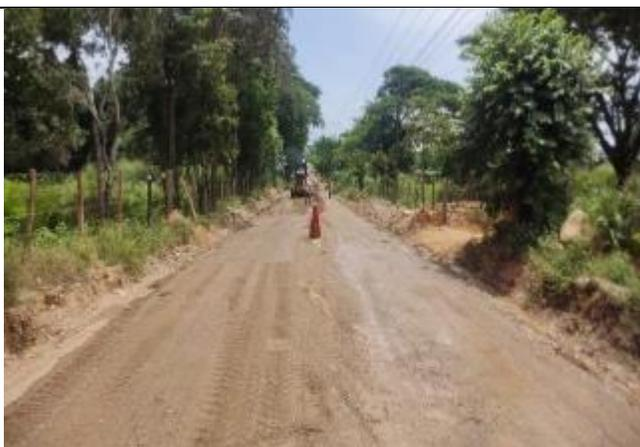
Instalación de subbase granular  $e=0.20m$ .
