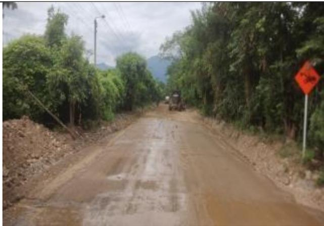
Instalación de subbase granular  $e=0.20m$ .
