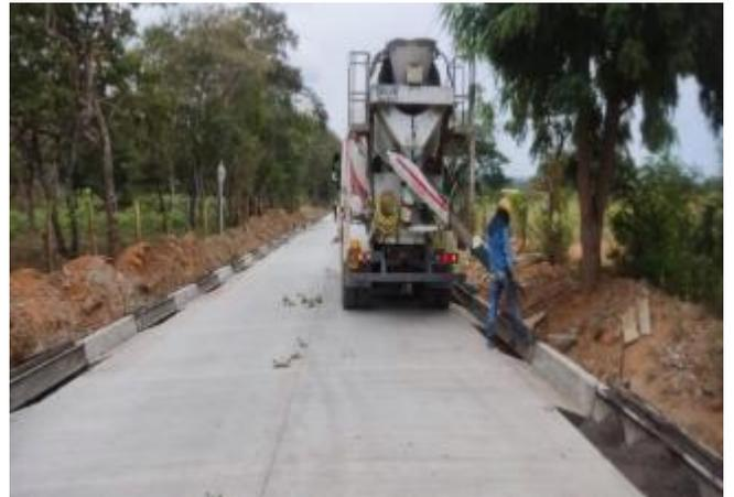
Instalación de bordillo en concreto
