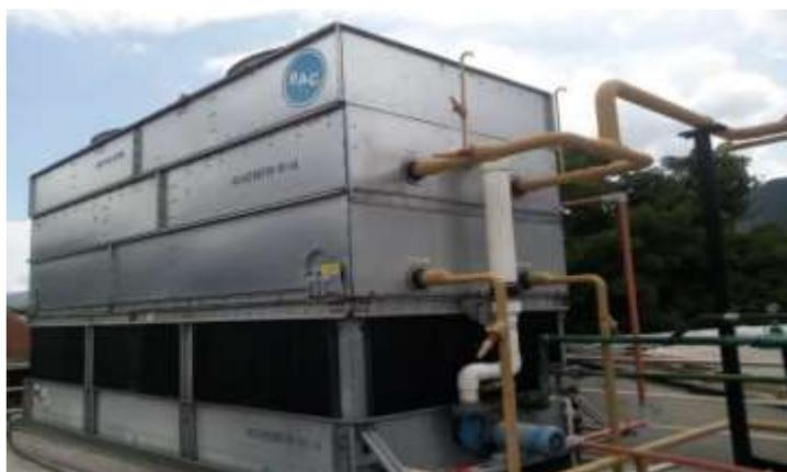
Figura 13. Condensador evaporativo BAC- CXVE.
