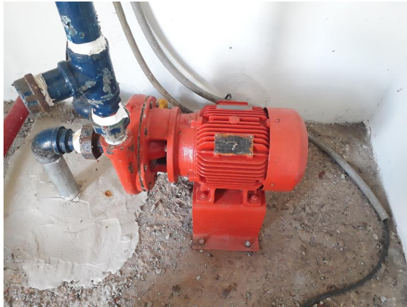
Figura 20. Motobomba encargada de cargar el Hidroflo. Fuente: autor.
