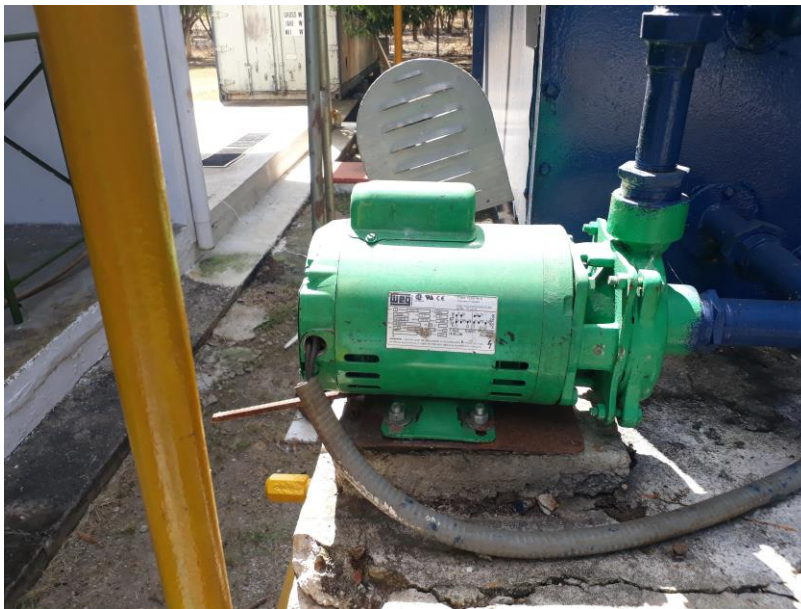
Figura 11. Motobomba encargada de impulsar el agua a las culatas del compresor de amoníaco. Fuente: autor.
