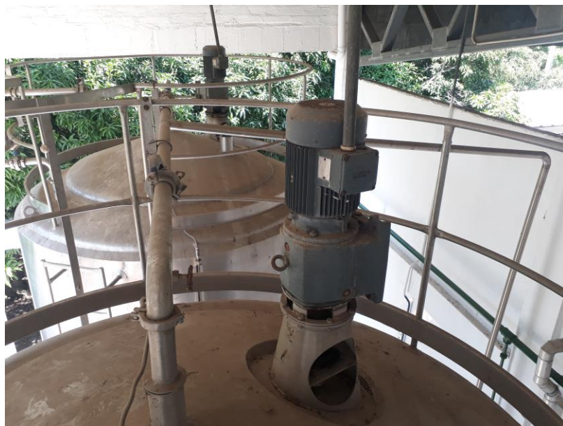
Figura 16. Motor reductor que agitan la leche del silo #1 y #2 respectivamente. Fuente: autor.
