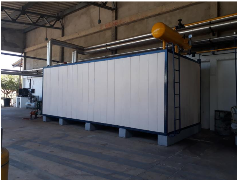
Figura 12. Banco de hielo responsable de brindar el agua fría para las placas de refrigeración. Fuente: autor.
