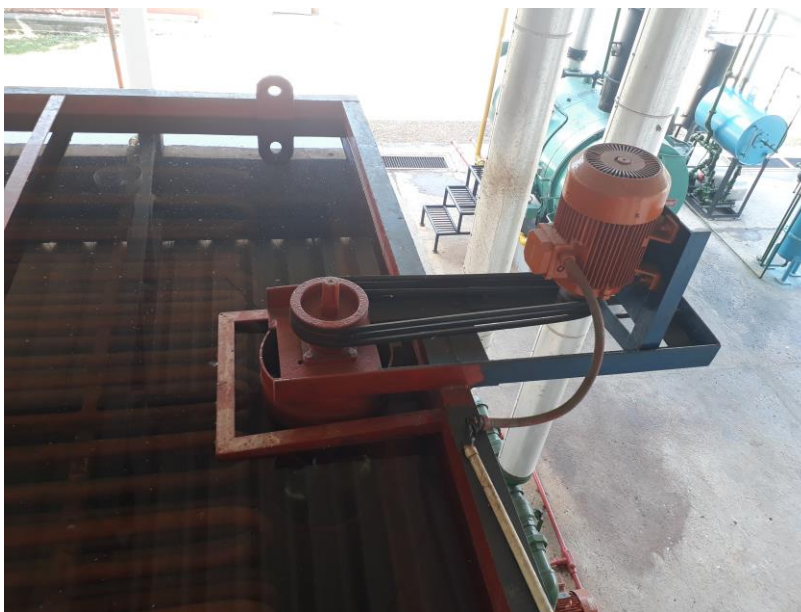
Figura 12. Banco de hielo responsable de brindar el agua fría para las placas de refrigeración. Fuente: autor.
