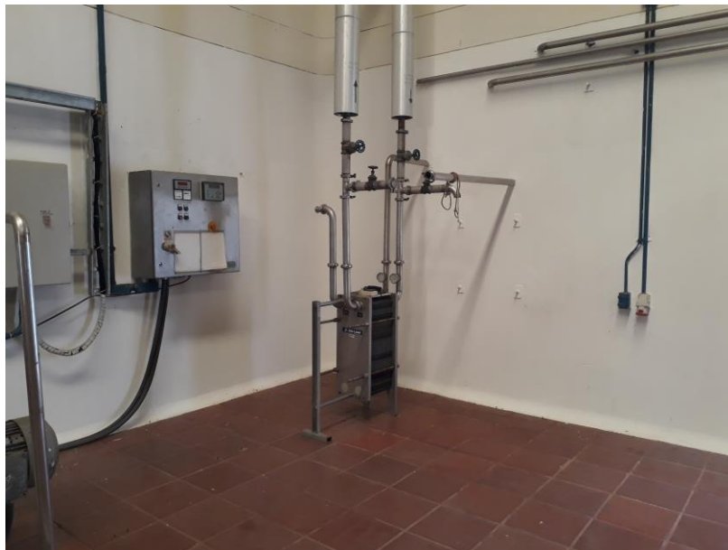
Figura 6. Intercambiador de calor por placas con volumen de 38,7 litros. Fuente: autor.
