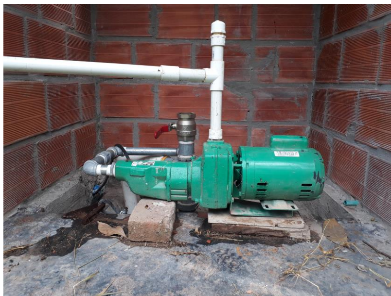
Figura 18. Bomba lapicero ubicada en el fondo del pozo. Fuente: autor.
