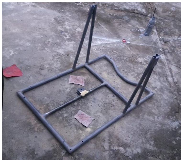
Figura 57. Unión de la tubería y lijado. Fuente: Autores del proyecto.
