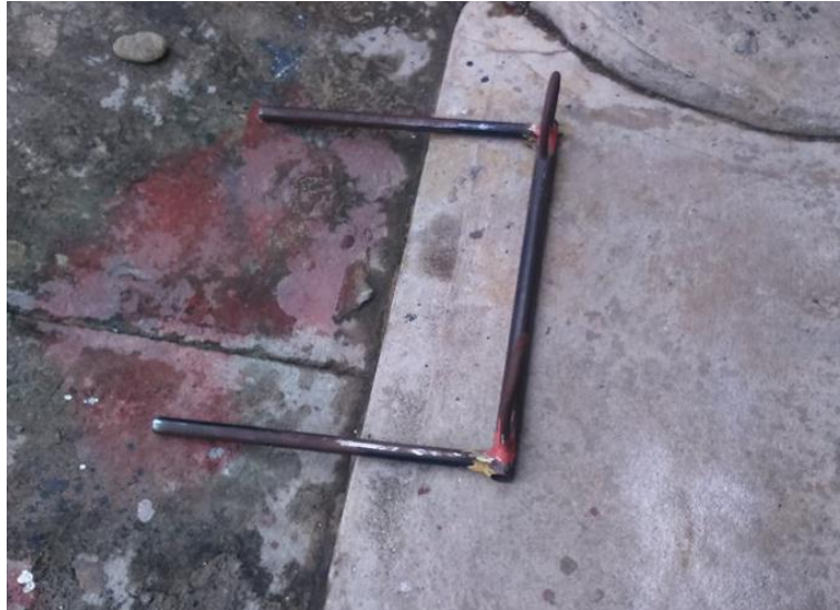
Figura 56. Unión de la tubería. Fuente: Autores del proyecto.
