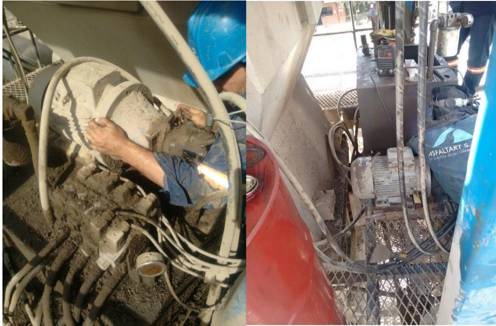
Figura 25. Mantenimiento realizado a la unidad hidráulica.
