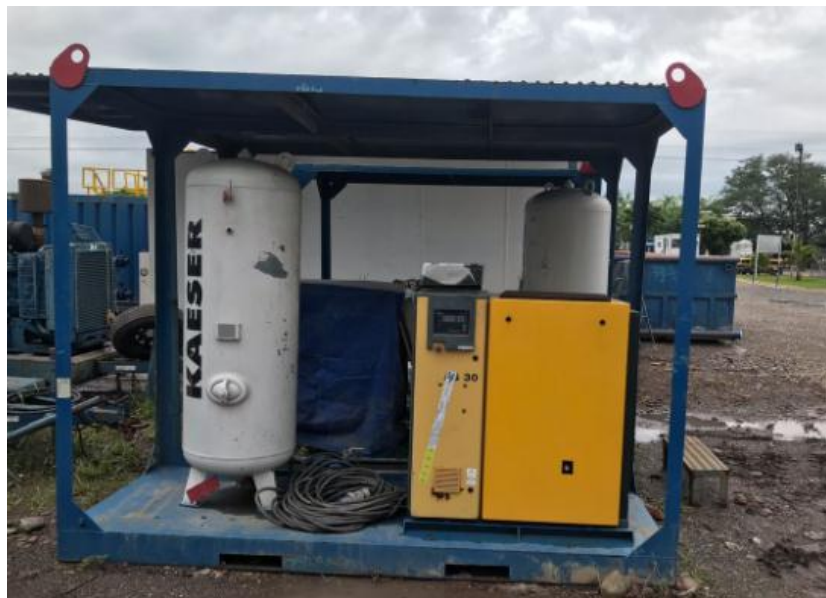
Figura 14. Compresor en prueba de funcionamiento Fuente. Pasante
