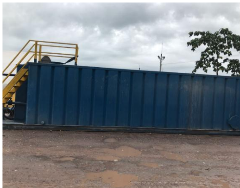
Figura 8 Fractank en inspección Fuente. Pasante
