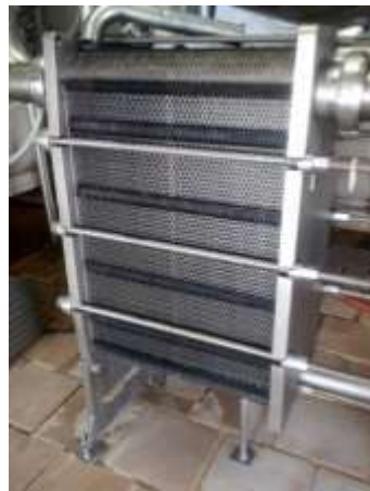
Imagen 2. Intercambiador de placas acopio planta Freskaleche
