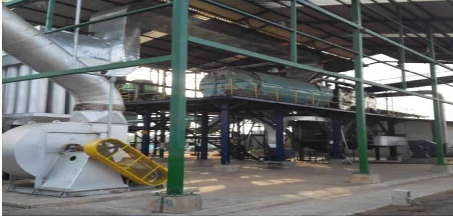
Fotografía 12. Caldera de vapor del tipo combinado – ventiladores – distribuidor de vapor – chimenea. Fuente: El autor.
