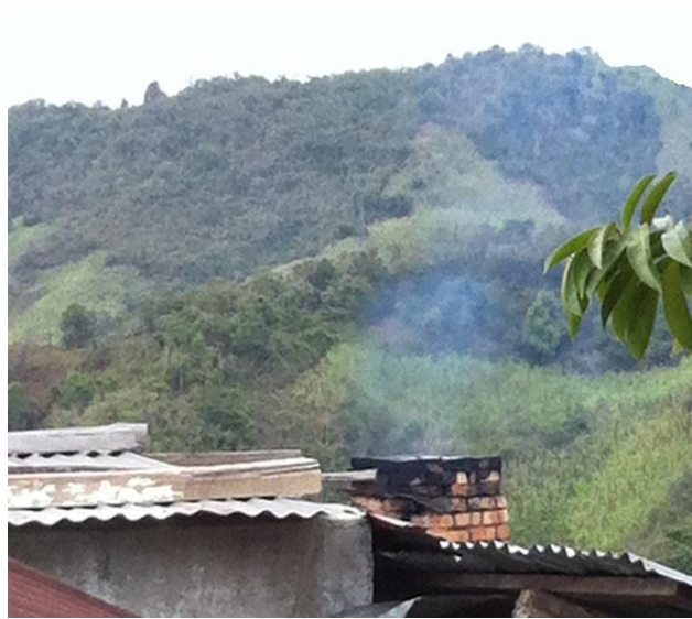
Figura 27. Chimenea de la hornilla
