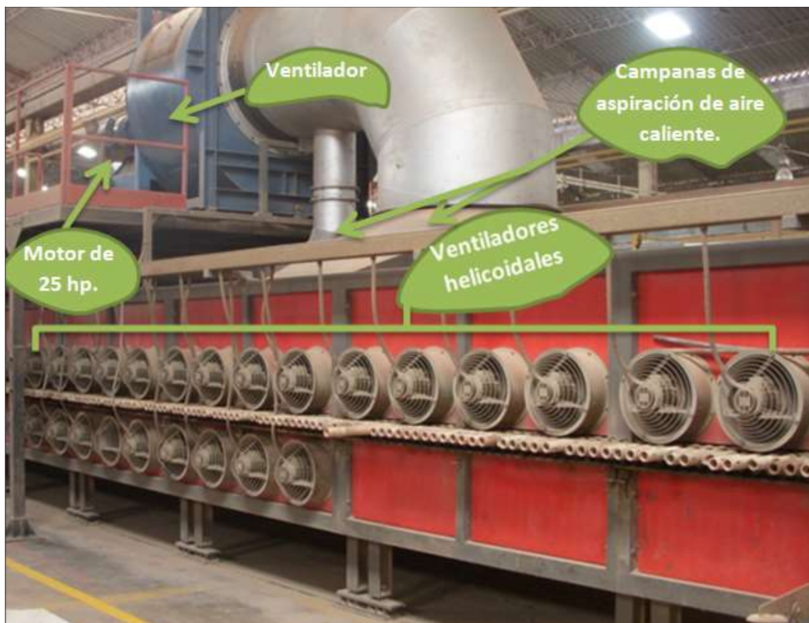
Fotografía 13. Zona de enfriamiento final.
