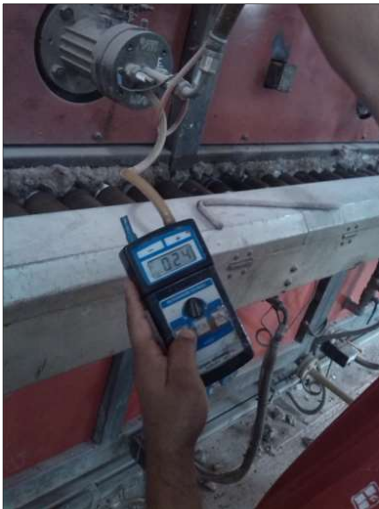
Fotografía 30. Regulación de un quemador.
