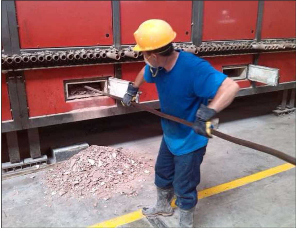
Fotografía 20. Remoción de rotura.
