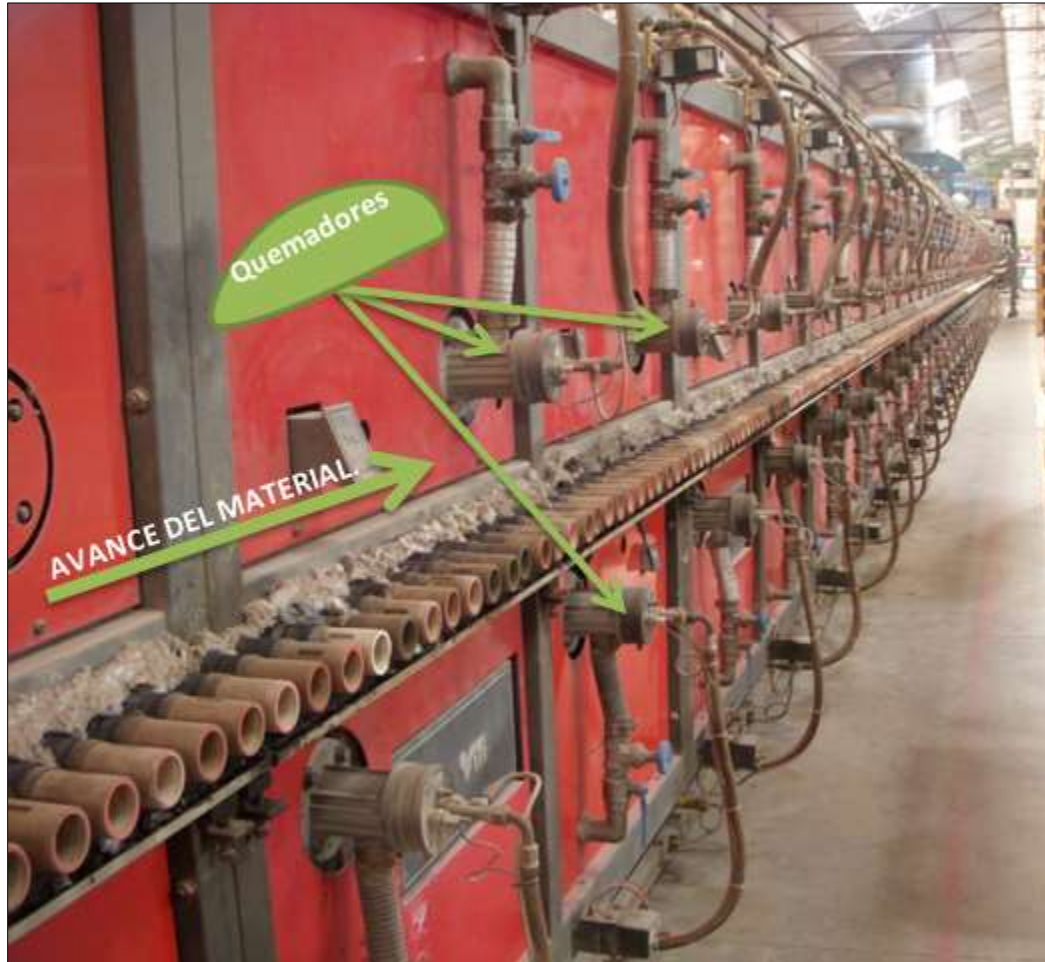
Fotografía 22. Zona con quemadores.
