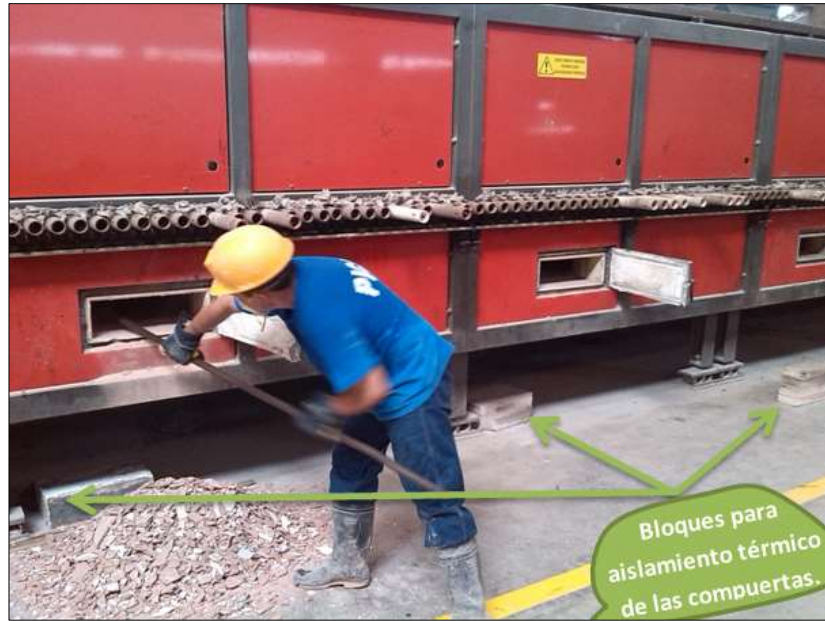
Fotografía 32. Limpieza de la cámara del horno.
