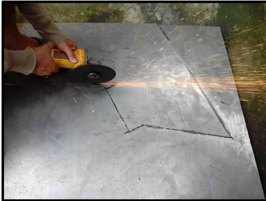
Figura 34. Construcción de la tolva de almacenamiento.
