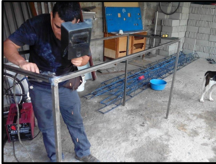
Figura 35. Construcción de la estructura metálica que soporta la máquina.
