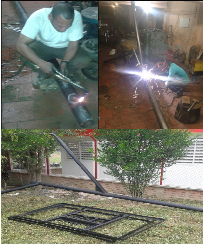
Figura 37. Construcción del árbol
