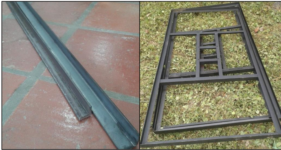
Figura 35. Estructura de soporte para paneles
