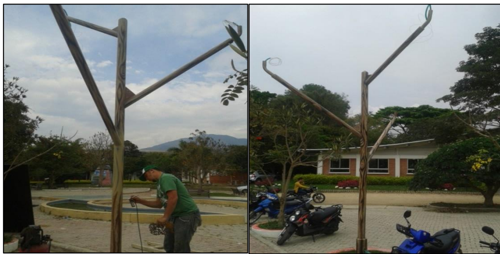
Figura 39. Aerografía a la estructura del árbol
