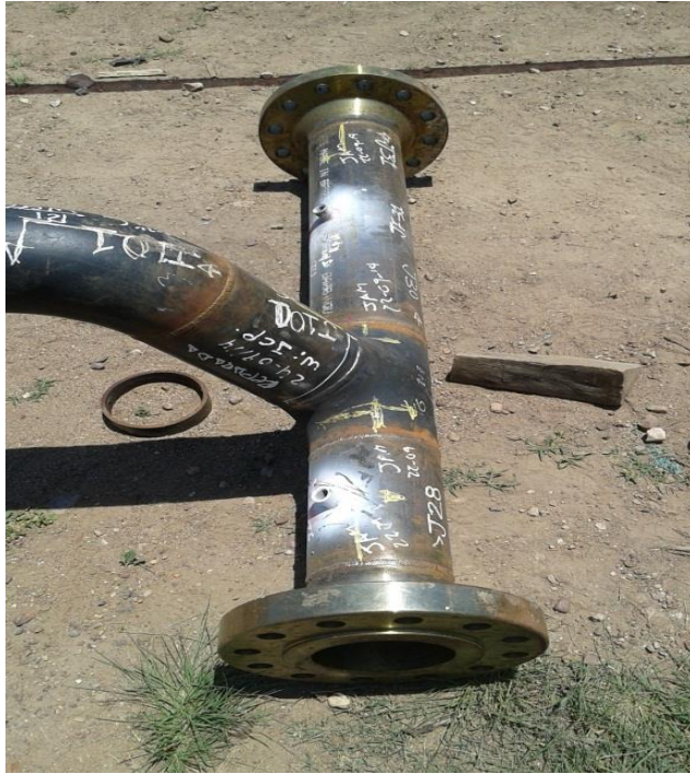
Foto 13. Disposición de tubería para realizar ensayos no destructivos.
