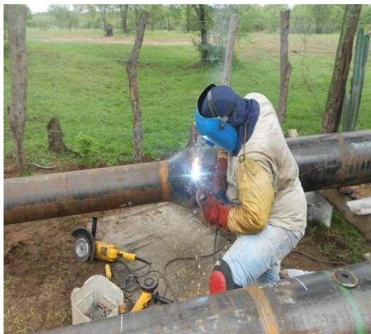
Foto 5. Alineación y soldadura, frentes de estaciones ERM, tubería de acero de 12”, trampas de envío y recibo.
