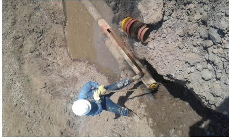
Foto 7. Limpieza de tubería, con cepillos de acero.
