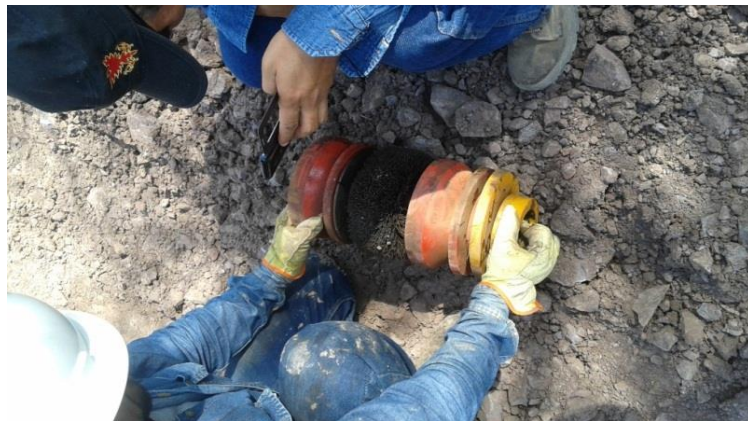
Foto 8. Limpieza de tubería, platina calibradora.
