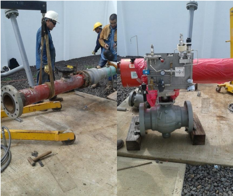
Foto 21. Montaje de válvulas seccionadoras.
