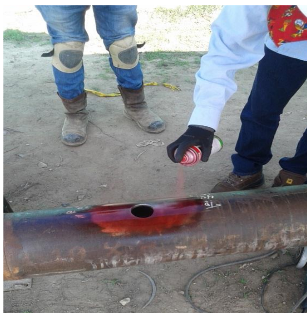
Foto 16. Realización de los ensayos no destructivos, líquidos penetrantes
