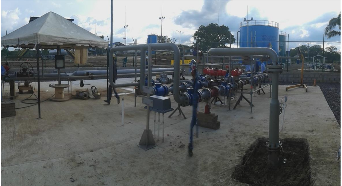
Foto 10. Prueba hidrostática en curso, estación de regulación y medición
