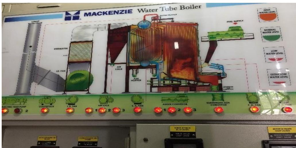
**Figura 18.** Tablero caldera Mackenzie – Distribuidor de vapor – Caldera
