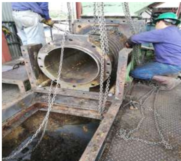
Figura 19 Desmonte canasta prensa de raquis
