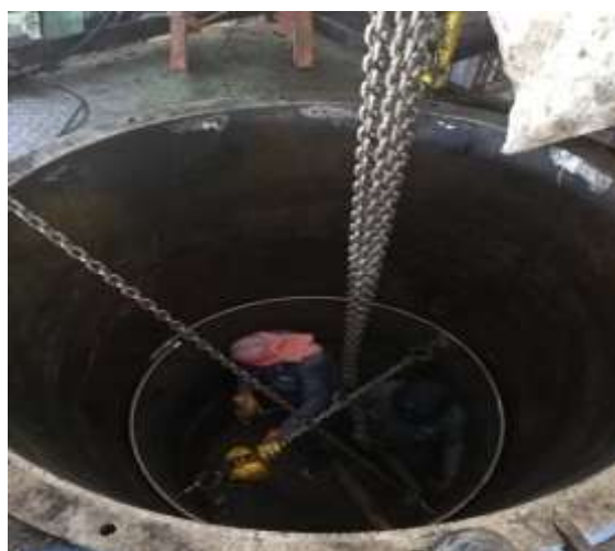
Figura 24 Montaje de camisa de desgaste del digestor
