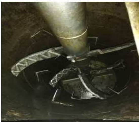
Figura 26 Montaje y acople de paletas del digestor
