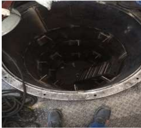
Figura 25 Montaje de frenos del digestor
