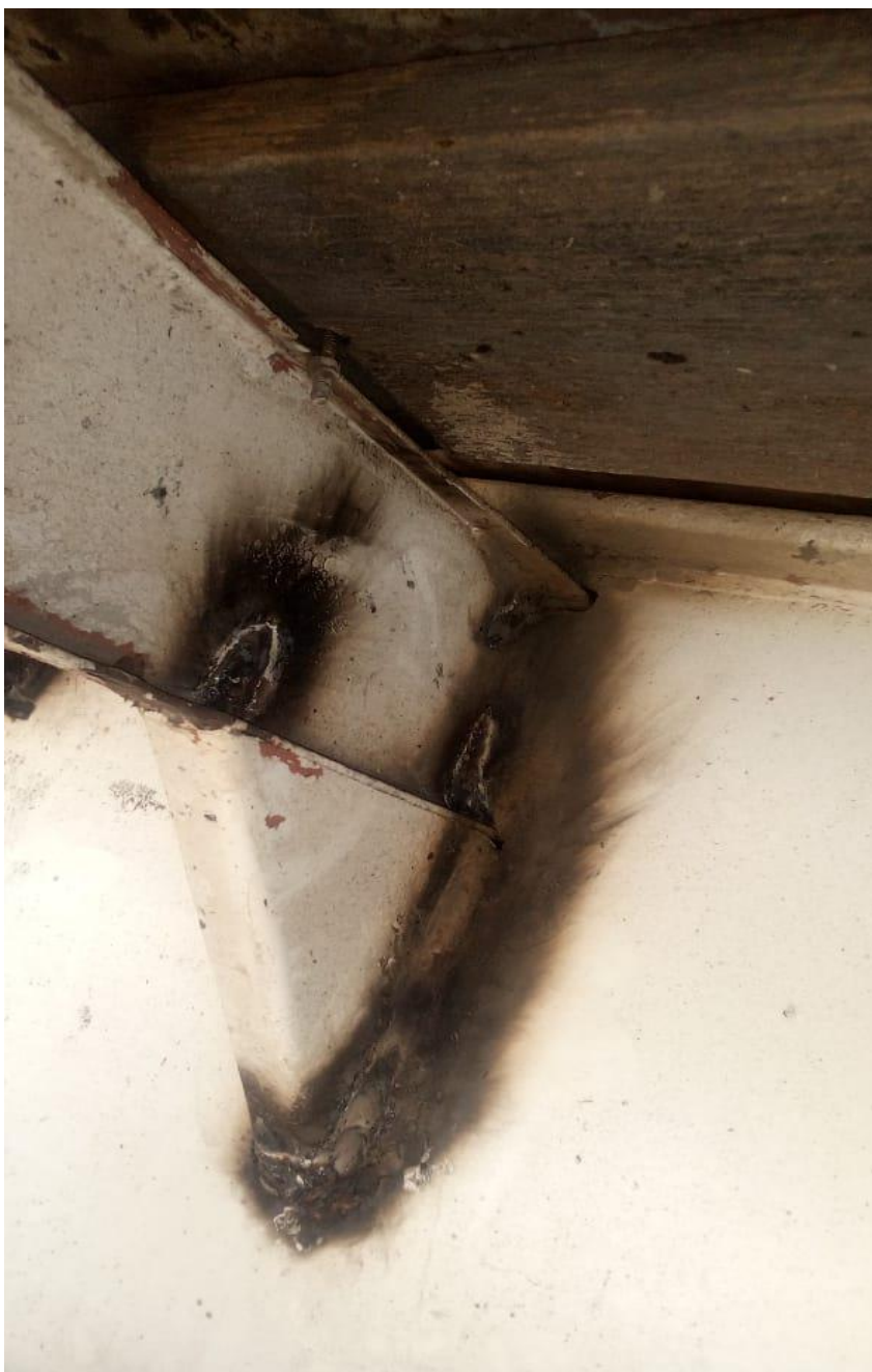
Figura 77. Soldadura a puentes S81610
