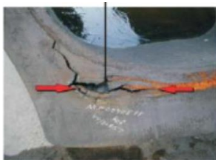
Figura 23. Separación mecánica del hombro
